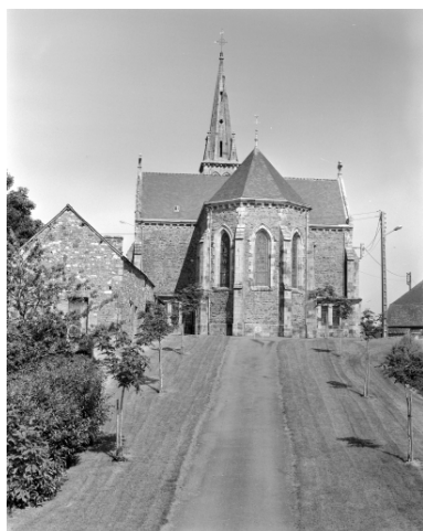
Elévation Ouest : vue générale
