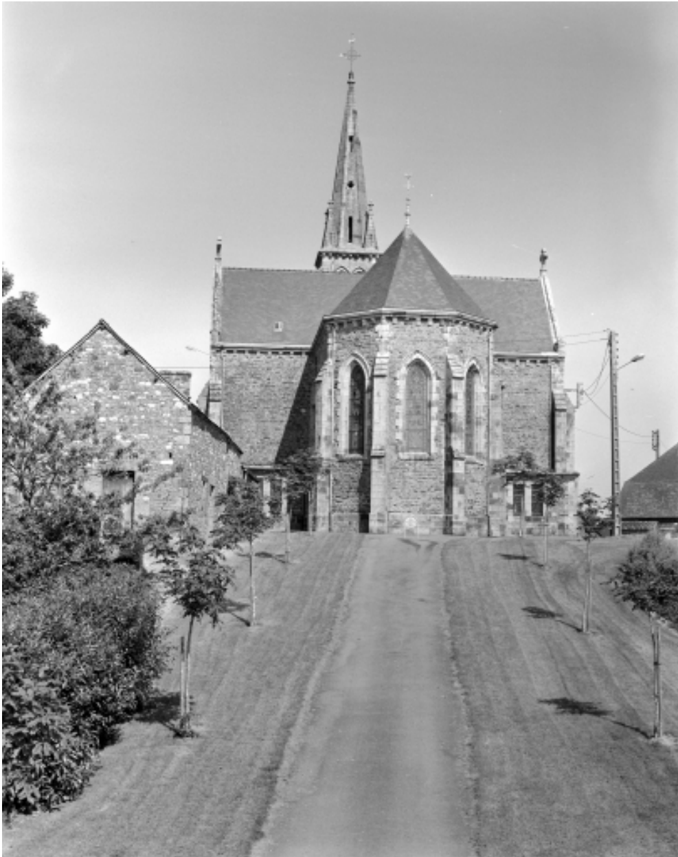
Elévation Ouest : vue générale
