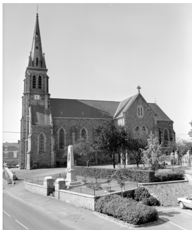
Elévation Nord : vue générale
