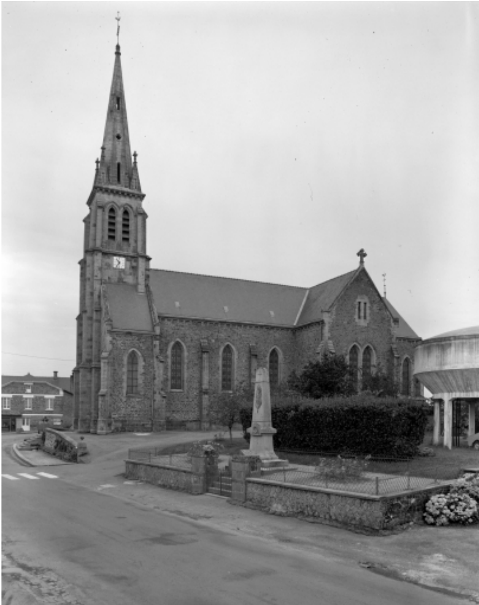
Elévation Nord : vue générale
