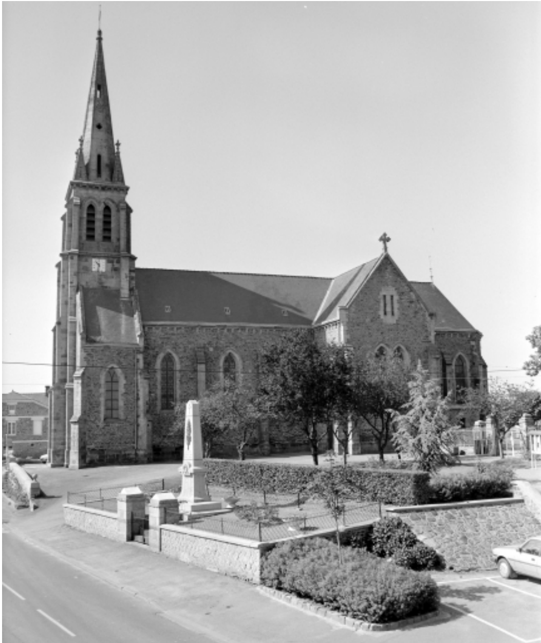
Elévation Nord : vue générale
