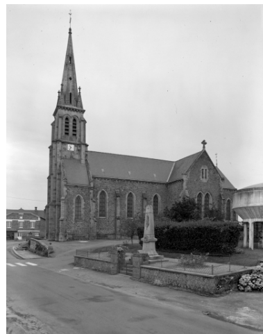
Elévation Nord : vue générale
