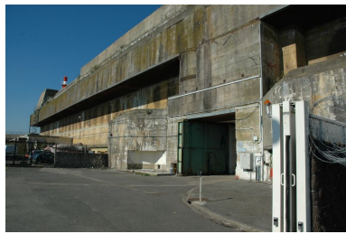
Vue de l'entrée est du bunker "KIII" flanquée de deux bunkers casemates pour mitrailleuse et surmontée d'une casemate (2005) Phot. Guillaume Lécueillier IVR53_20055603566NUCA
