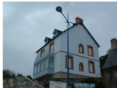
Vue de trois-quarts d'une maison de conserveur, côté mer Phot. Julien Amghar IVR53_20062908623NUCA
