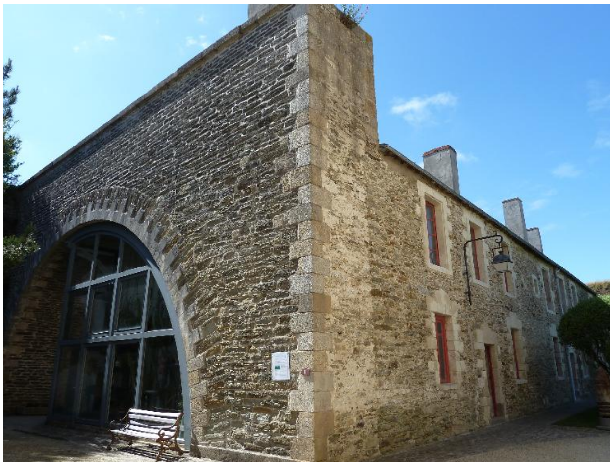
Le Palais, citadelle, cavalier du bastion 2, traverse en maçonnerie sur arc appuyée sur le pignon du pavillon d'officiers.
