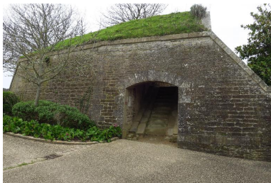
Le Palais, citadelle, cavalier du bastion 2, flanc ouest, débouché inférieur de l'escalier-rampe. Phot. Lionel Duigou IVR53_20175606691NUCA
