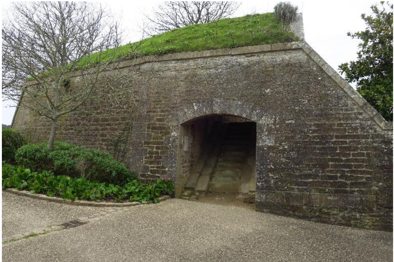
Le Palais, citadelle, cavalier du bastion 2, flanc ouest, débouché inférieur de l'escalier-rampe.
