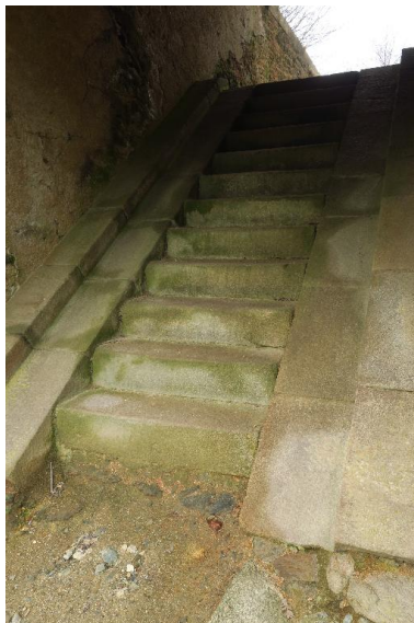
Le Palais, citadelle, cavalier du bastion 2, escalier-rampe. Phot. Lionel Duigou IVR53_20175606724NUCA
