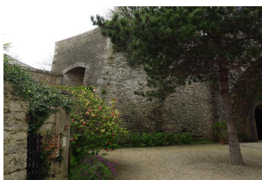
Le Palais, citadelle, cavalier du bastion 2, passage couvert à la gorge de l'ouvrage. Phot. Lionel Duigou IVR53_20175606727NUCA
