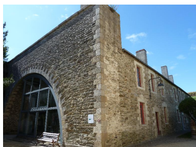
Le Palais, citadelle, cavalier du bastion 2, traverse en maçonnerie sur arc appuyée sur le pignon du pavillon d'officiers. Phot. Patrick Jadé IVR53_20175606729NUCA
