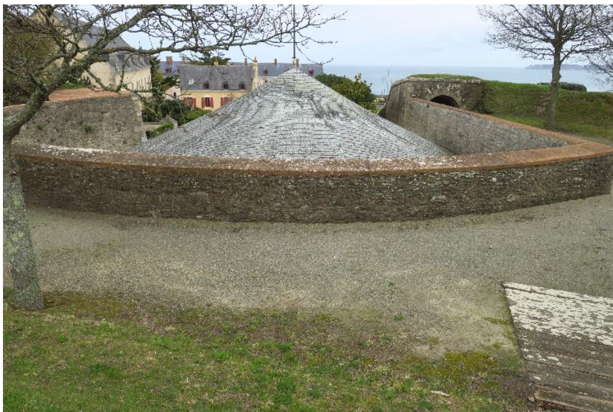
Le Palais, citadelle, cavalier du bastion 2, terre-plein autour du magasin à poudre circulaire.
