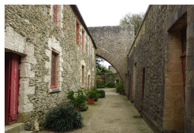
Le Palais, citadelle, cavalier du bastion 2, traverse en maçonnerie sur arc appuyée sur le pignon du pavillon d'officiers. Phot. Lionel Duigou IVR53_20175606731NUCA
