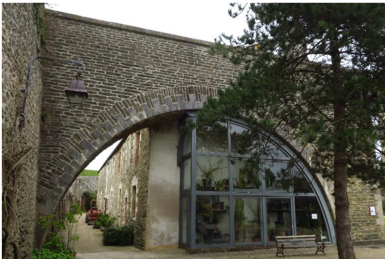
Le Palais, citadelle, cavalier du bastion 2, traverse en maçonnerie sur arc appuyée sur le pignon du pavillon d'officiers.
