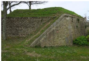
Le Palais, citadelle, cavalier du bastion 2, mur de soutènement des terrassements disparus et escarpe du 17e siècle dégagée par les restaurations. Phot. Lionel Duigou IVR53_20175606721NUCA
