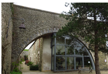
Le Palais, citadelle, cavalier du bastion 2, traverse en maçonnerie sur arc appuyée sur le pignon du pavillon d'officiers. Phot. Lionel Duigou IVR53_20175606730NUCA
