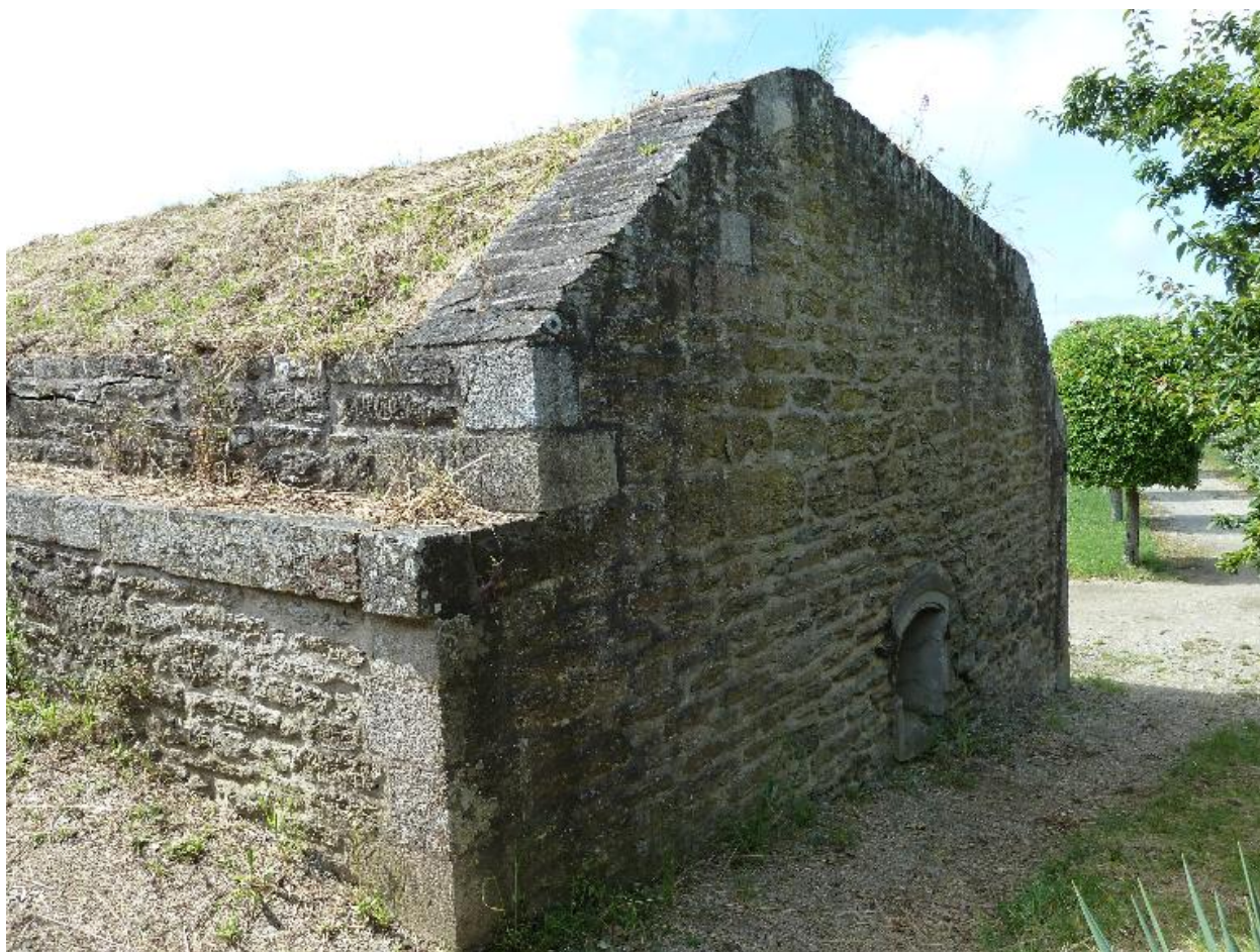
Le Palais, citadelle, cavalier du bastion 2, niche à munitions à la queue du parapet.
