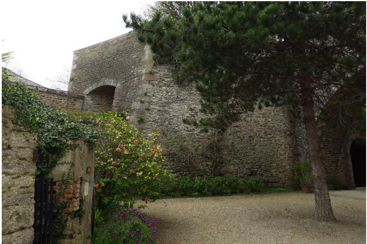
Le Palais, citadelle, cavalier du bastion 2, passage couvert à la gorge de l'ouvrage.
