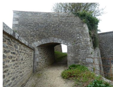
Le Palais, citadelle, cavalier du bastion 2, passage couvert à la gorge de l'ouvrage. Phot. Patrick Jadé IVR53_20175606728NUCA
