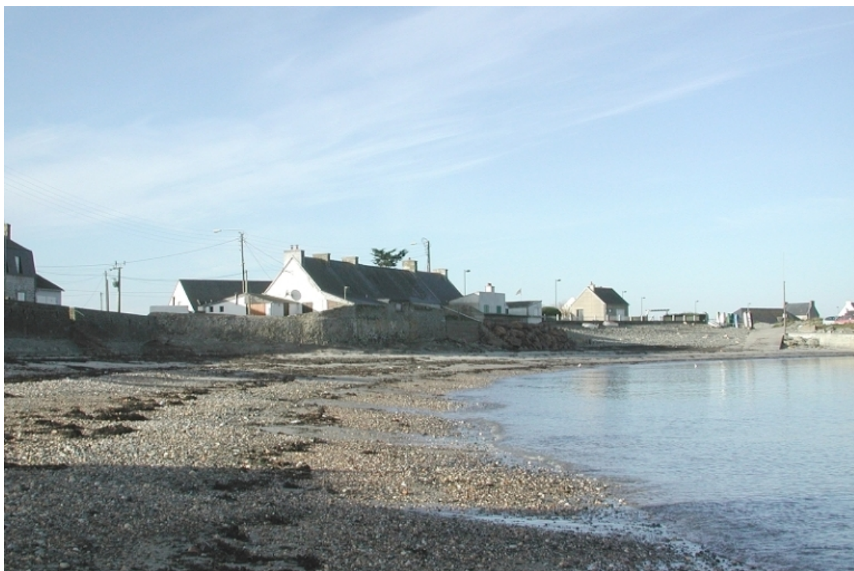
Murets de soutènement et cale aménagés autour de l'ancien cordon de galets
