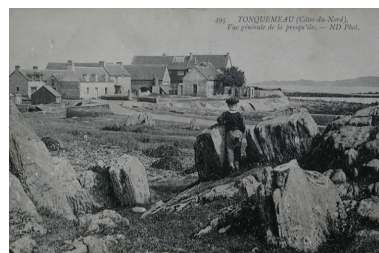
Les murs de soutènement devant les bâtiments du port au début du 20ème siècle Repro. Guy Prigent, Autr. N. D. IVR53_20042204558NUCB
