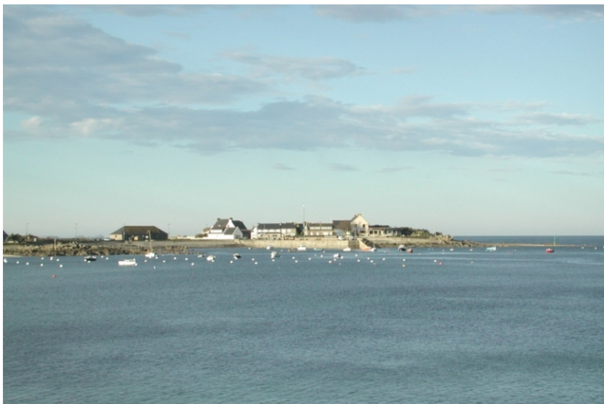
Vue générale du port de Locquémeau aujourd'hui avec les aménagements portuaires
