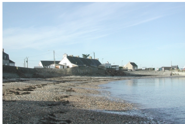
Murets de soutènement et cale aménagés autour de l'ancien cordon de galets Phot. Guy Prigent IVR53_20042204331NUCA
