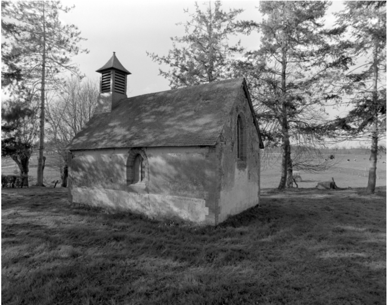
Elévation Sud : vue générale
