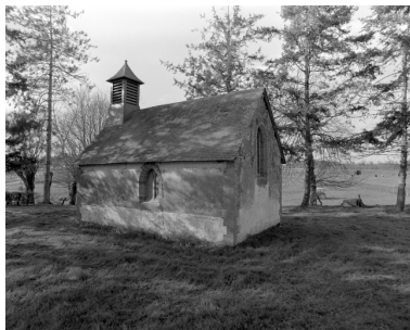
Elévation Sud : vue générale Phot. Bernard Bègne, Phot. M. Loyon IVR53_19933500353X
