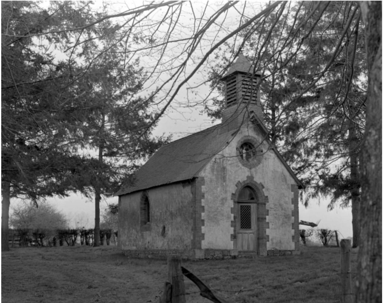
Elévation Nord-Ouest : vue générale
