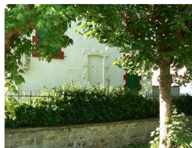
Villa Ker Suzanne, côté rue Phot. Johan Vincent IVR53_20072908679NUCA
