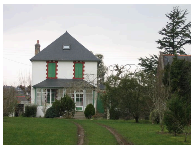
Vue générale de la villa Ker Suzanne Phot. Françoise Péron IVR53_20062908632NUCA
