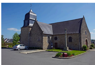
Vue générale : côté nord-ouest Phot. Véronique Samson IVR53_20133501674NUCA
