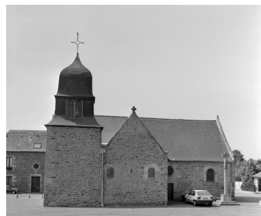
Elévation Nord : vue générale Phot. Guy Artur, Phot. Norbert Lambart IVR53_19943501453X
