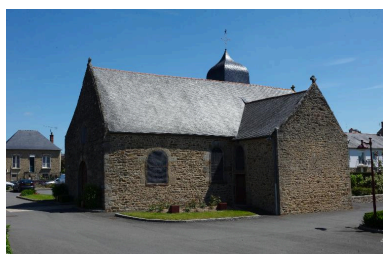
Vue générale : côté sud-ouest Phot. Véronique Samson IVR53_20133501639NUCA
