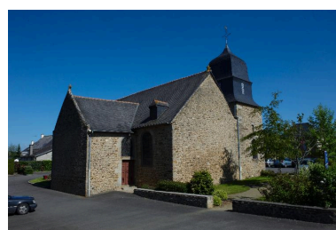
Vue générale : côté sud-est Phot. Véronique Samson IVR53_20133501628NUCA
