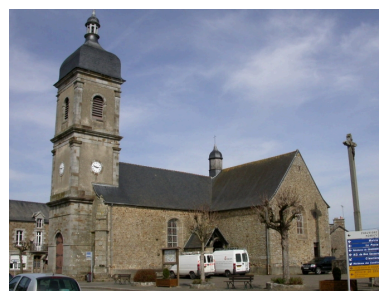
Vue sud-ouest Phot. Stéphanie Ménard IVR53_20053507311NUCA
