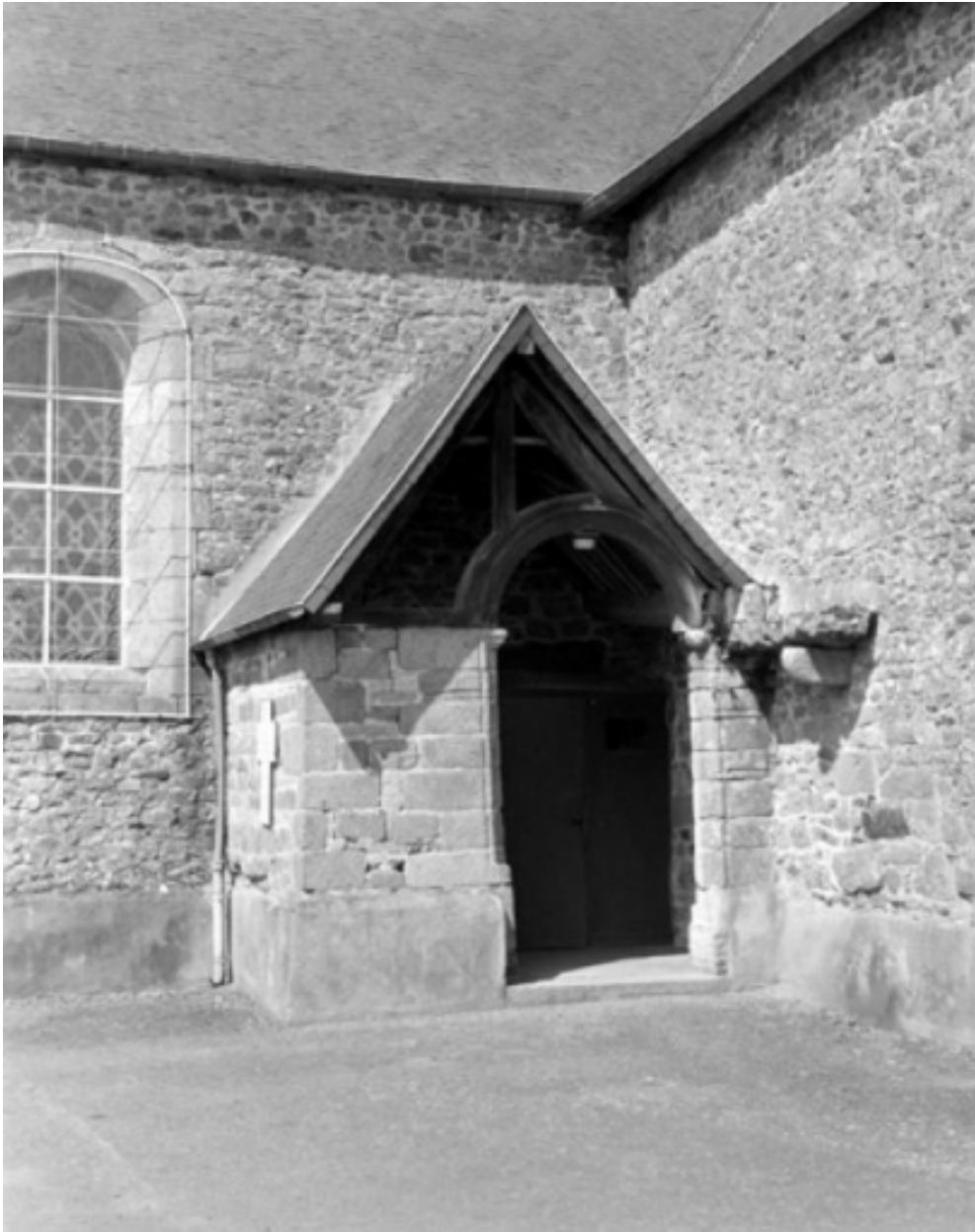
Elévation sud, porche : vue générale
