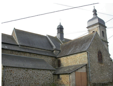
Vue nord-est Phot. Stéphanie Ménard IVR53_20053507313NUCA
