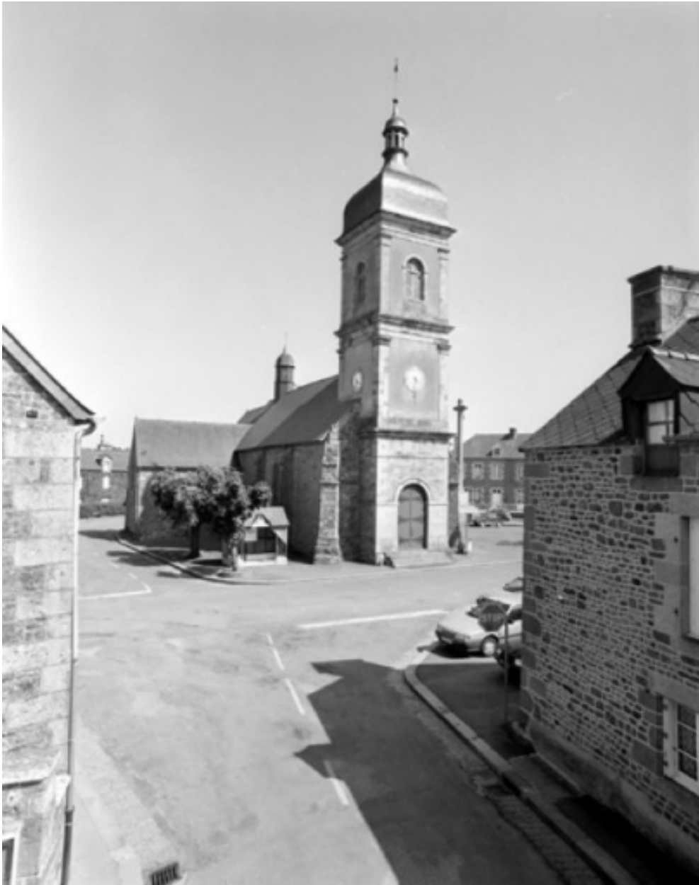
Elévation ouest : vue générale
