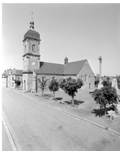
Elévation sud-ouest : vue générale Phot. Guy Artur, Phot. Norbert Lambart IVR53_19943500972X
