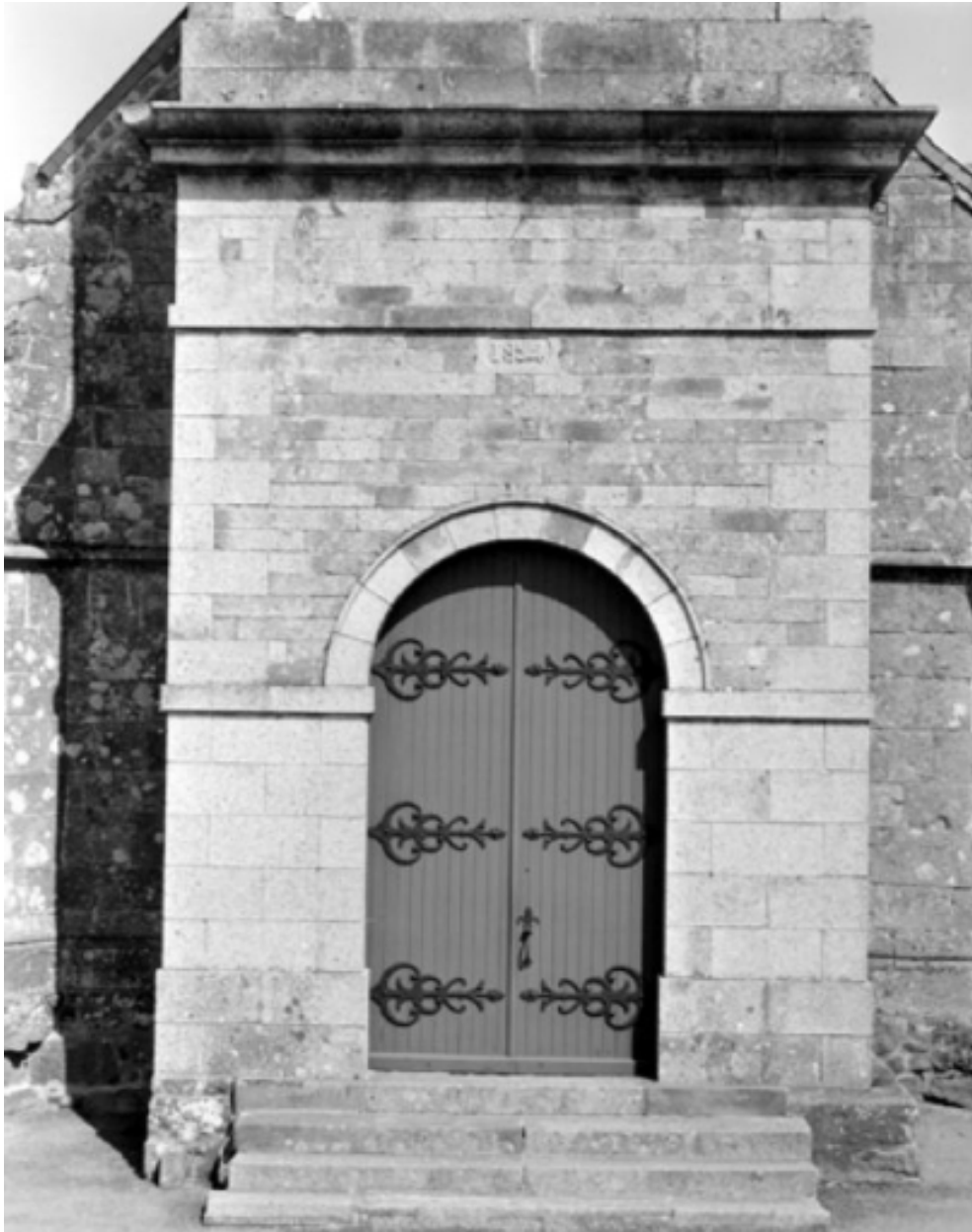
Elévation ouest, porte principale : vue générale
