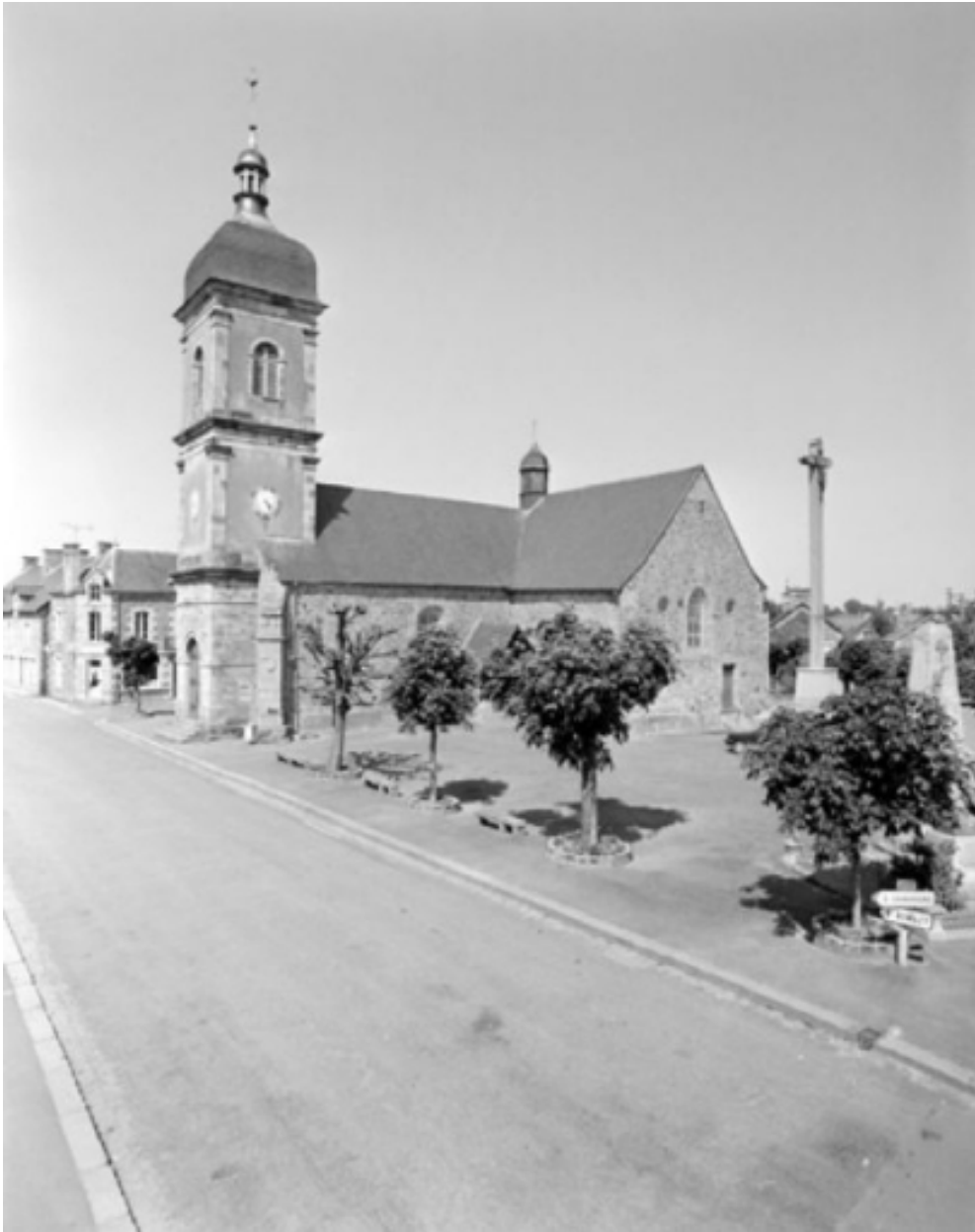
Elévation sud-ouest : vue générale
