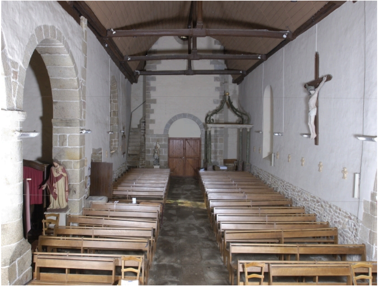
Vue intérieure prise du chœur vers la nef
