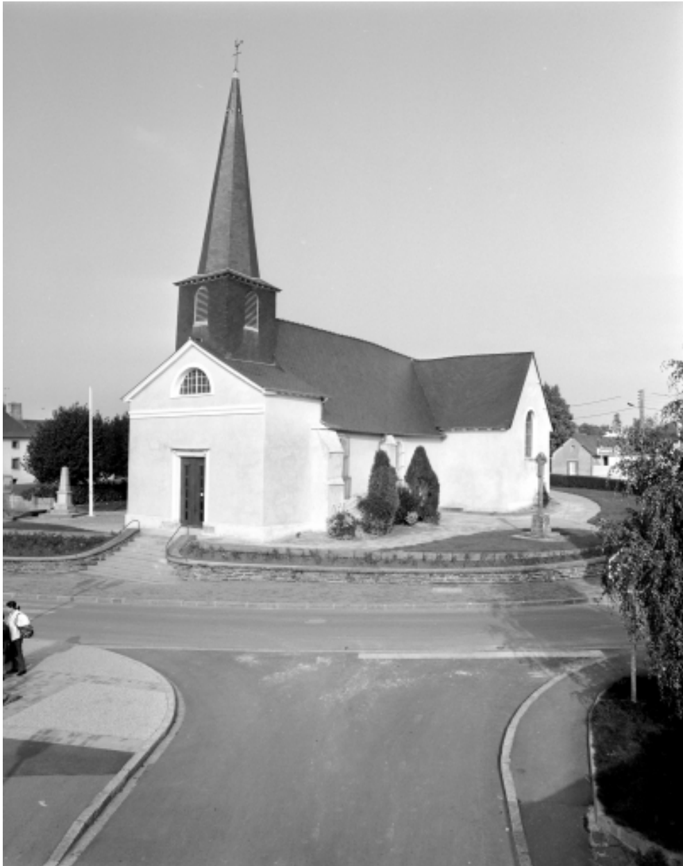
Elévation sud-ouest : vue générale
