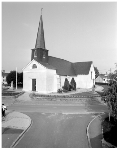
Elévation sud-ouest : vue générale Phot. Guy Artur, Phot. Norbert Lambart IVR53_19943501916X
