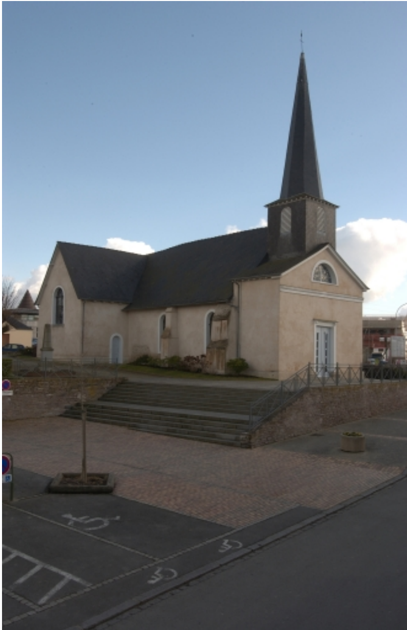
Elévation nord-est : vue générale
