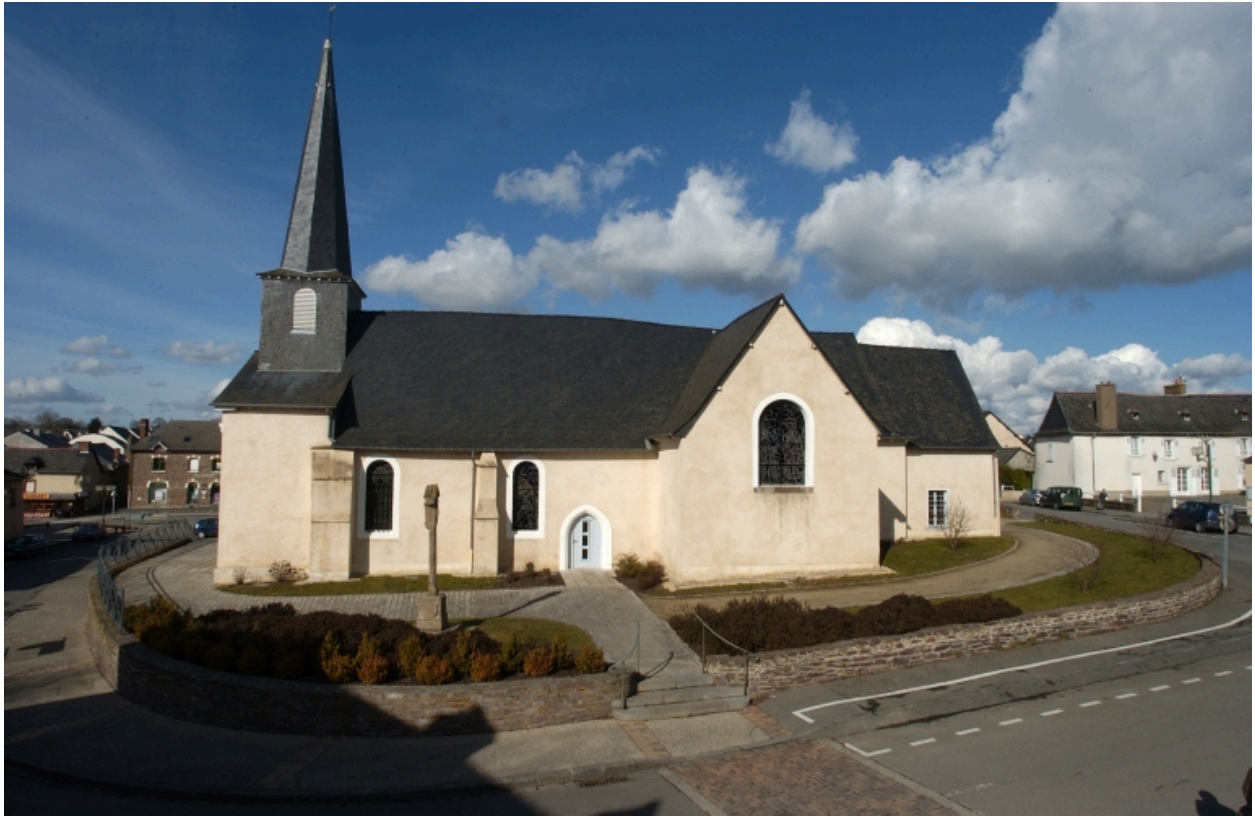
Elévation sud : vue générale
