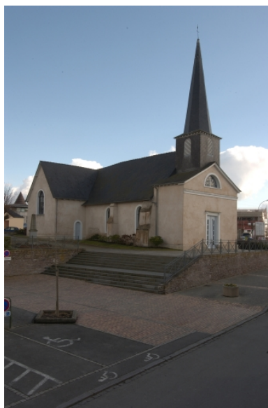
Elévation nord-est : vue générale Phot. Norbert Lambart IVR53_20063500198NUCA
