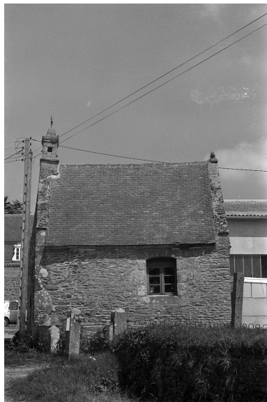
Vue générale de la façade sud
