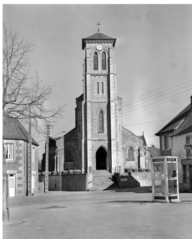
Elévation Ouest : vue générale Phot. Guy Artur, Phot. Norbert Lambart IVR53_19783500093X
