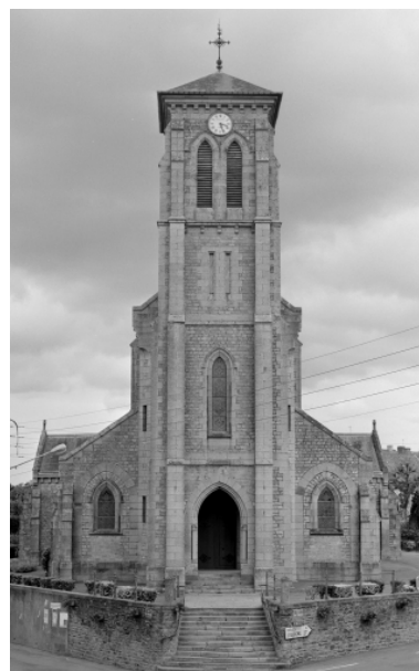
Elévation Ouest : vue générale Phot. Guy Artur, Phot. Norbert Lambart IVR53_19943501311X
