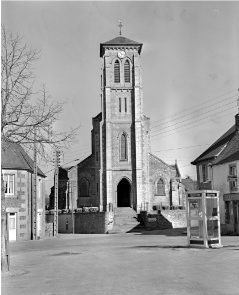
Elévation Ouest : vue générale
