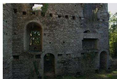
Vue intérieure du corps de bâtiment sud-est adossé à la courtine, mur sud-est : sous-sol et rez-de-chaussée (baie en arc plein cintre à coussiège avec ouverture de tir de type canonnière, cheminées, soupiraux du sous-sol en arc plein cintre et emplacement des poutres des planchers sont visibles)
