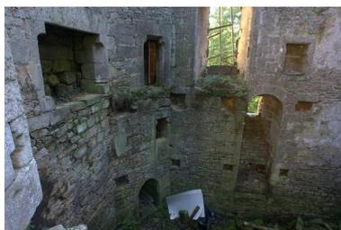
Vue intérieure du corps de bâtiment sud-est adossé à la courtine, extrémité est et tour d'angle au niveau du rez-de-chaussée (baies à coussiège, portes à linteau droit sur coussinet, cheminées, placards muraux et emplacement des poutres des planchers sont visibles)
