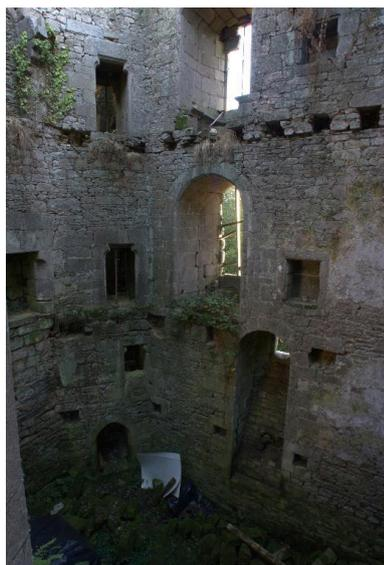
Vue intérieure du corps de bâtiment sud-est adossé à la courtine, extrémité est et tour d'angle : deux niveaux de sous-sol, rez-de-chaussée et premier étage (baies à coussiège, portes à sur coussinet, cheminées, placards muraux et emplacement des poutres des planchers sont visibles)
