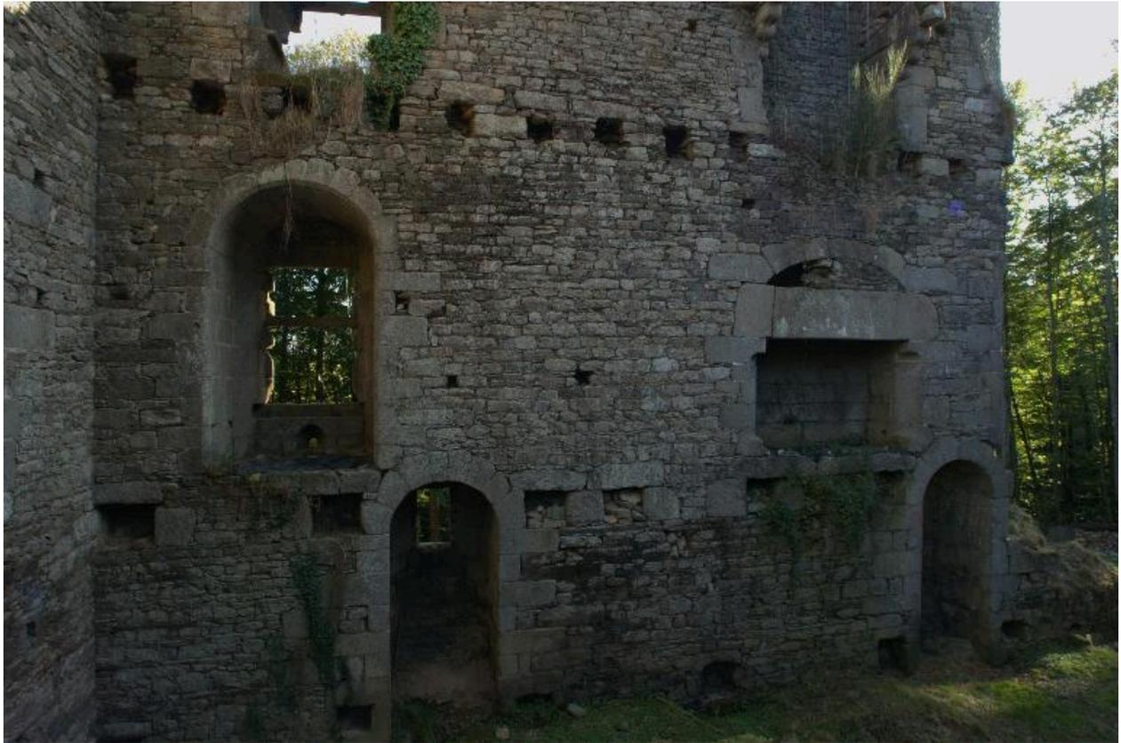
Vue intérieure du corps de bâtiment sud-est adossé à la courtine, mur sud-est : sous-sol et rez-de-chaussée (baie en arc plein cintre à coussiège avec ouverture de tir de type canonnrière, cheminées, soupiraux du sous-sol en arc plein cintre et emplacement des poutres des planchers sont visibles)
