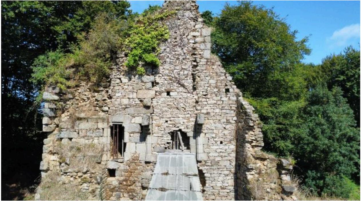
Vue aérienne : détail du pignon nord du corps de bâtiment sud-ouest. Au rez-de-chaussée, se trouvent des pièces domestiques et sur deux étages, des logements. Ici, le premier étage avec cheminée et porte à linteau sur coussinets
