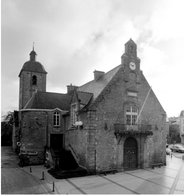
Elévation ouest : vue générale Phot. Guy Artur, Phot. Norbert Lambart IVR53_19943502410X
