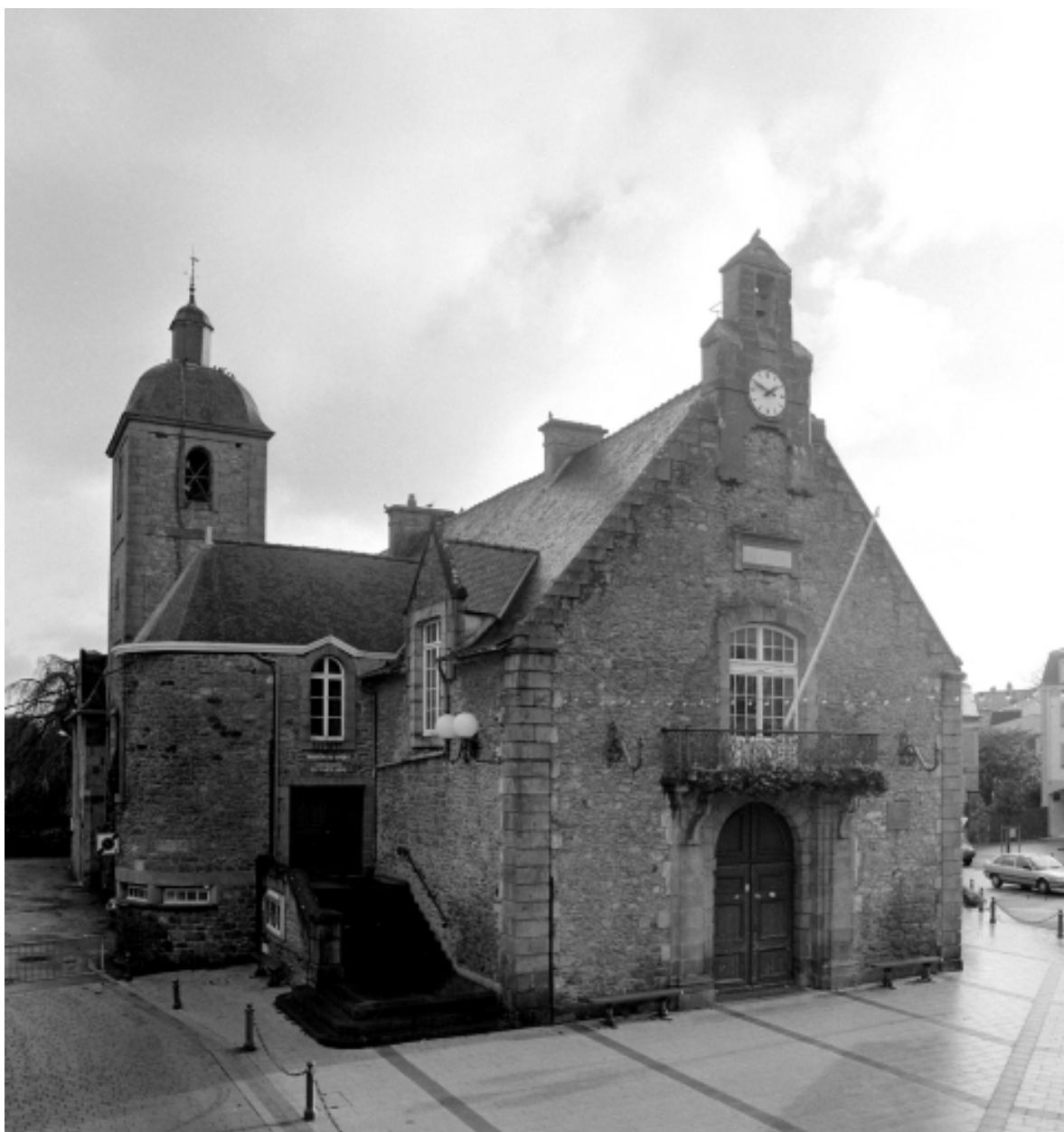
Elévation ouest : vue générale
