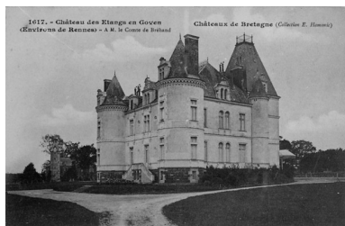
Vue générale Phot. Auteur inconnu IVR53_19883500251XB
