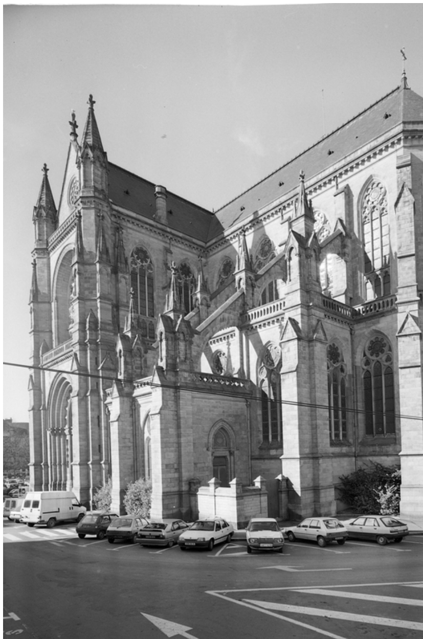
Elévation sud-est : vue générale.
