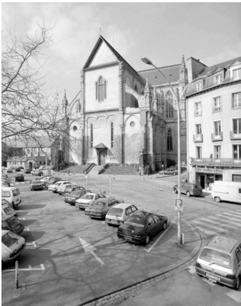
Elévation sud : vue générale
