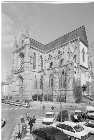
Elévation Sud-Ouest : vue générale. Phot. Guy Artur, Phot. Norbert Lambart IVR53_19953500202V
