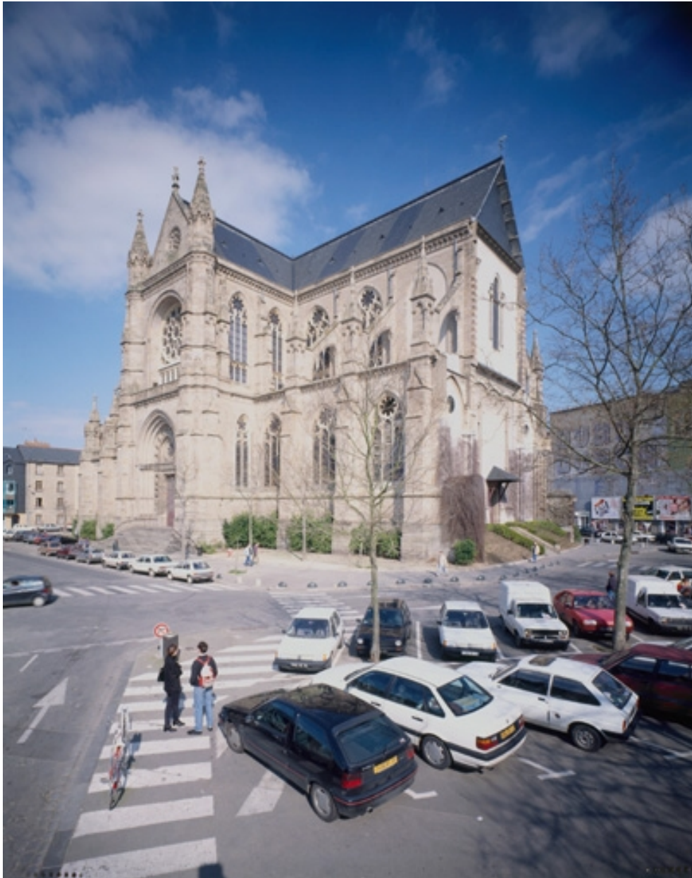
Elévation sud ouest : vue générale
