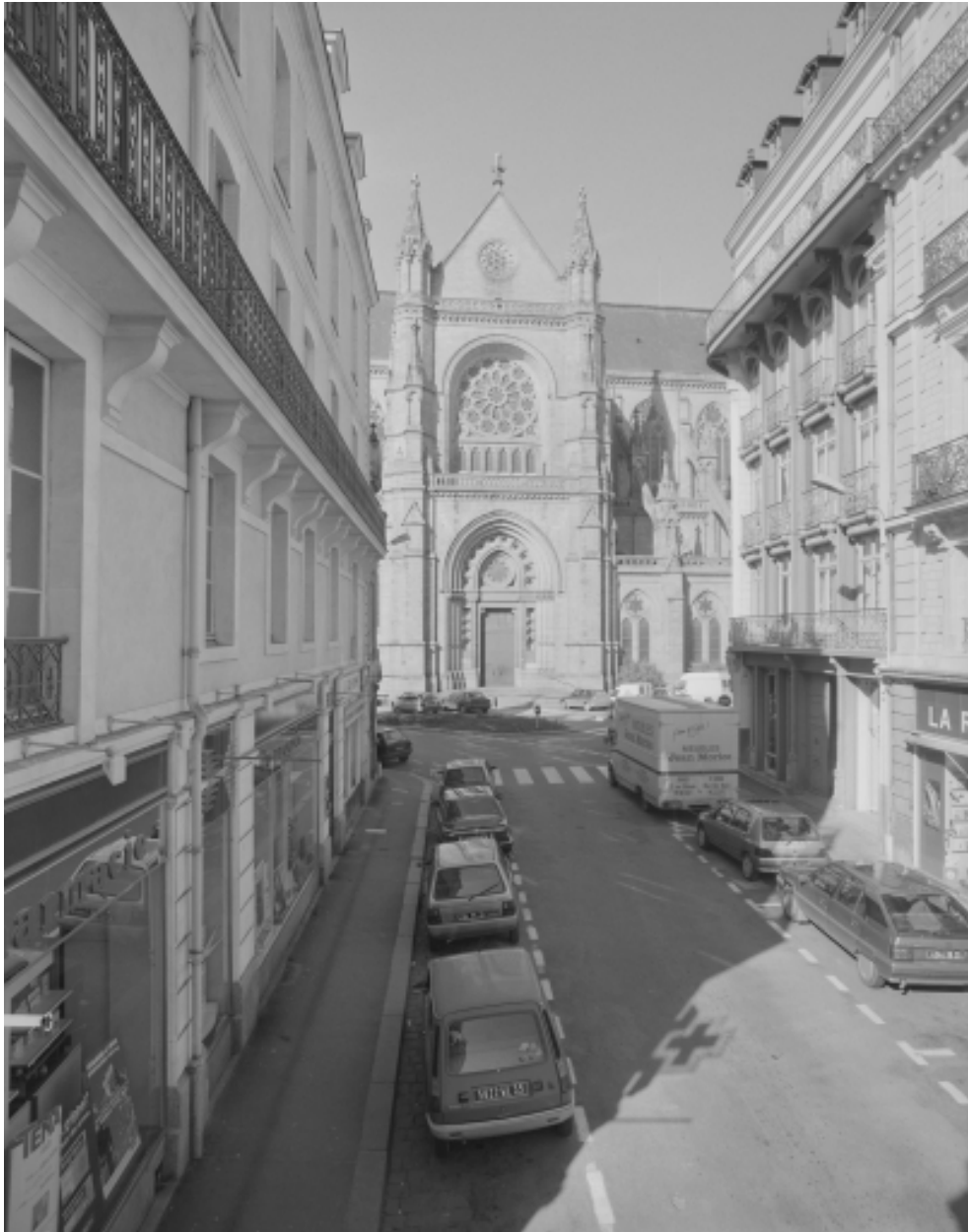
Elévation est : vue générale
