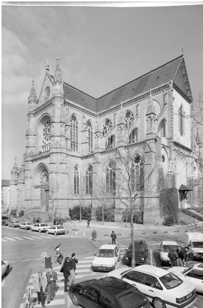
Elévation Sud-Ouest : vue générale.
