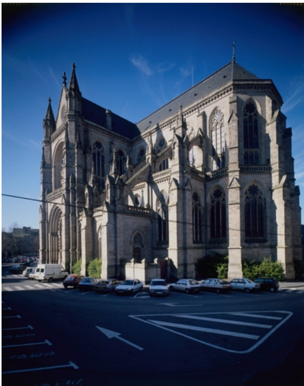
Elévation sud est : vue générale
