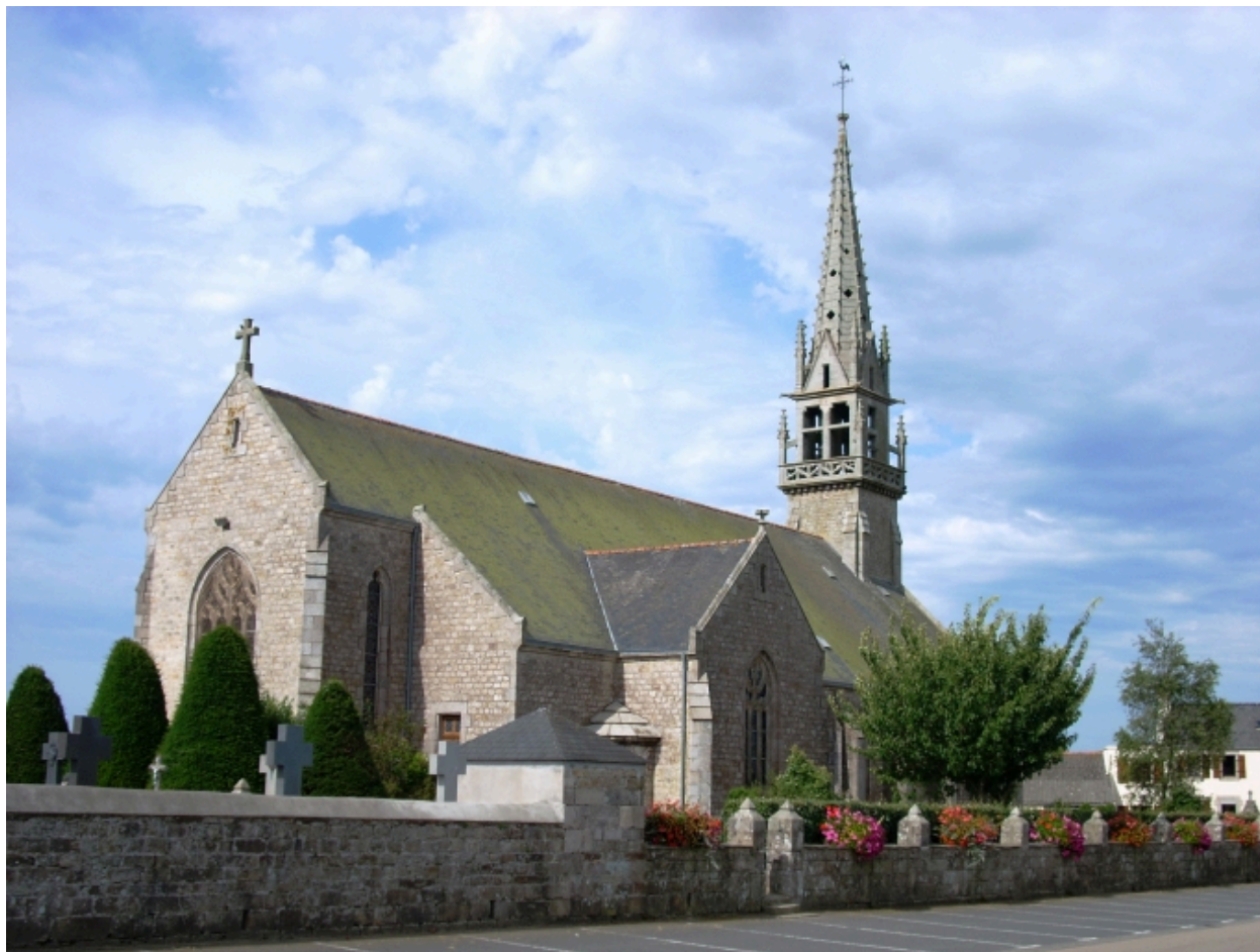
Mespaul, église paroissiale Saint-Eloi : vue générale nord-est
