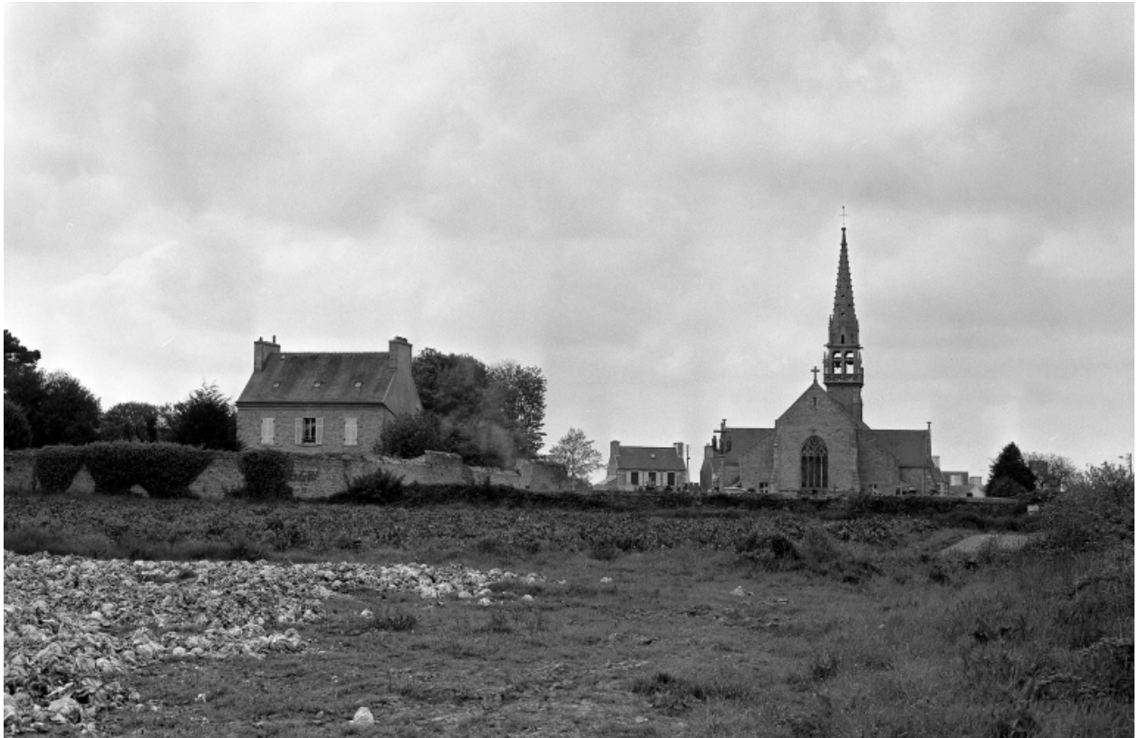
Mespaul, église paroissiale Saint-Eloi : vue d'ensemble prise de l'est, état en 1986
