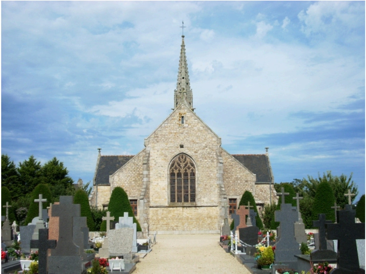
Mespaul, église paroissiale Saint-Eloi : élévation est
