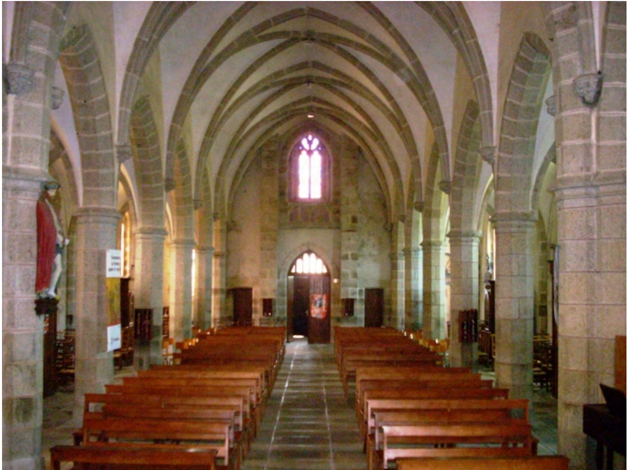
Mespaul, église paroissiale Saint-Eloi : vue axiale ouest
