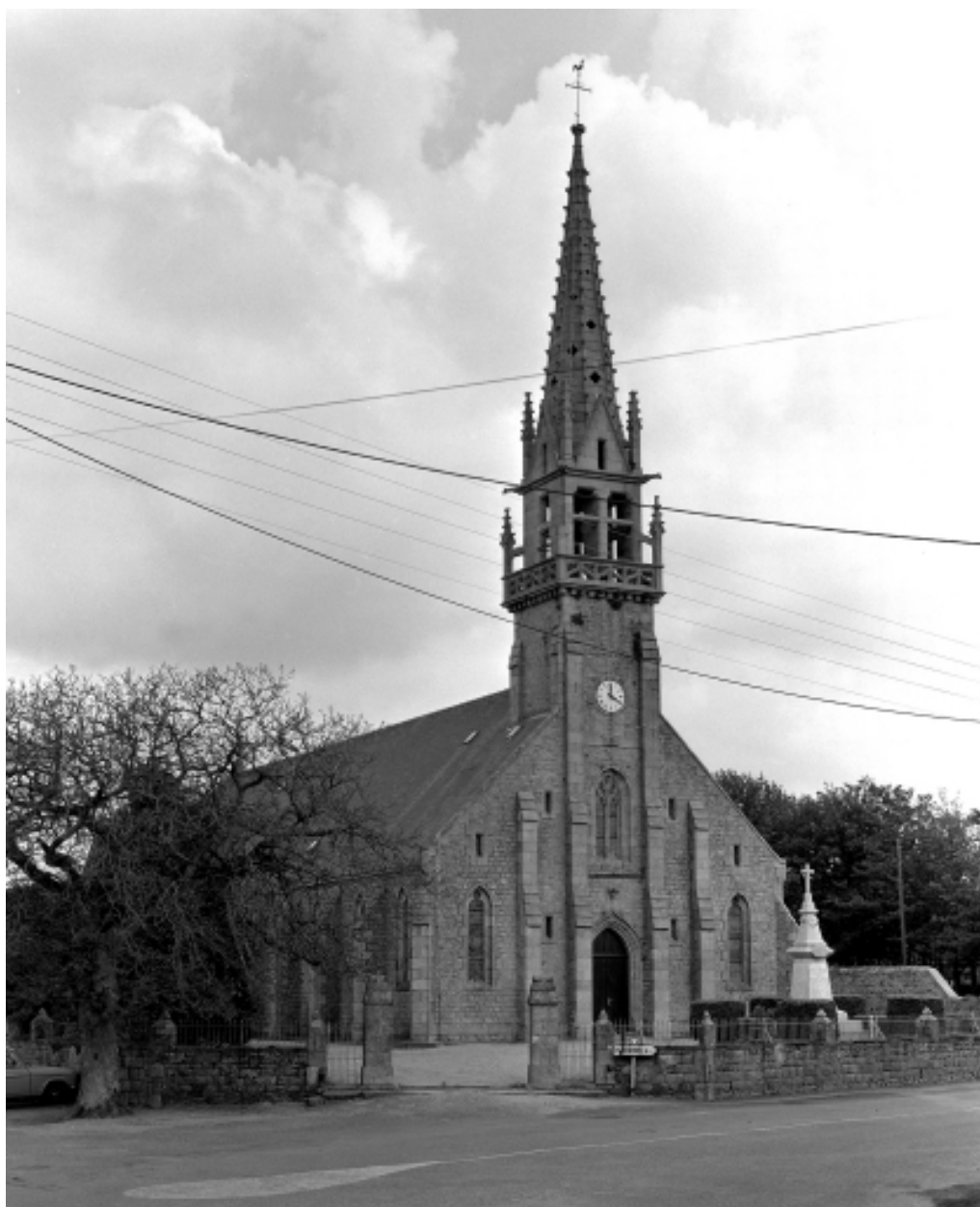
Mespaul, église paroissiale Saint-Eloi : vue générale nord-ouest, état en 1986
