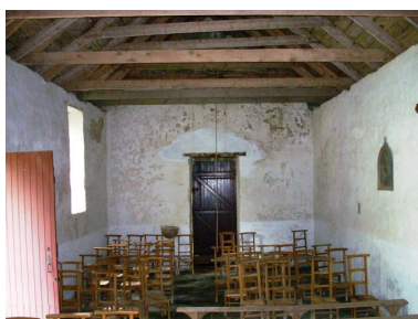
Saint-Sauveur, chapelle Saint-Yves : vue axiale ouest Phot. Gwénaél Fauchille IVR53_20082906456NUCA
