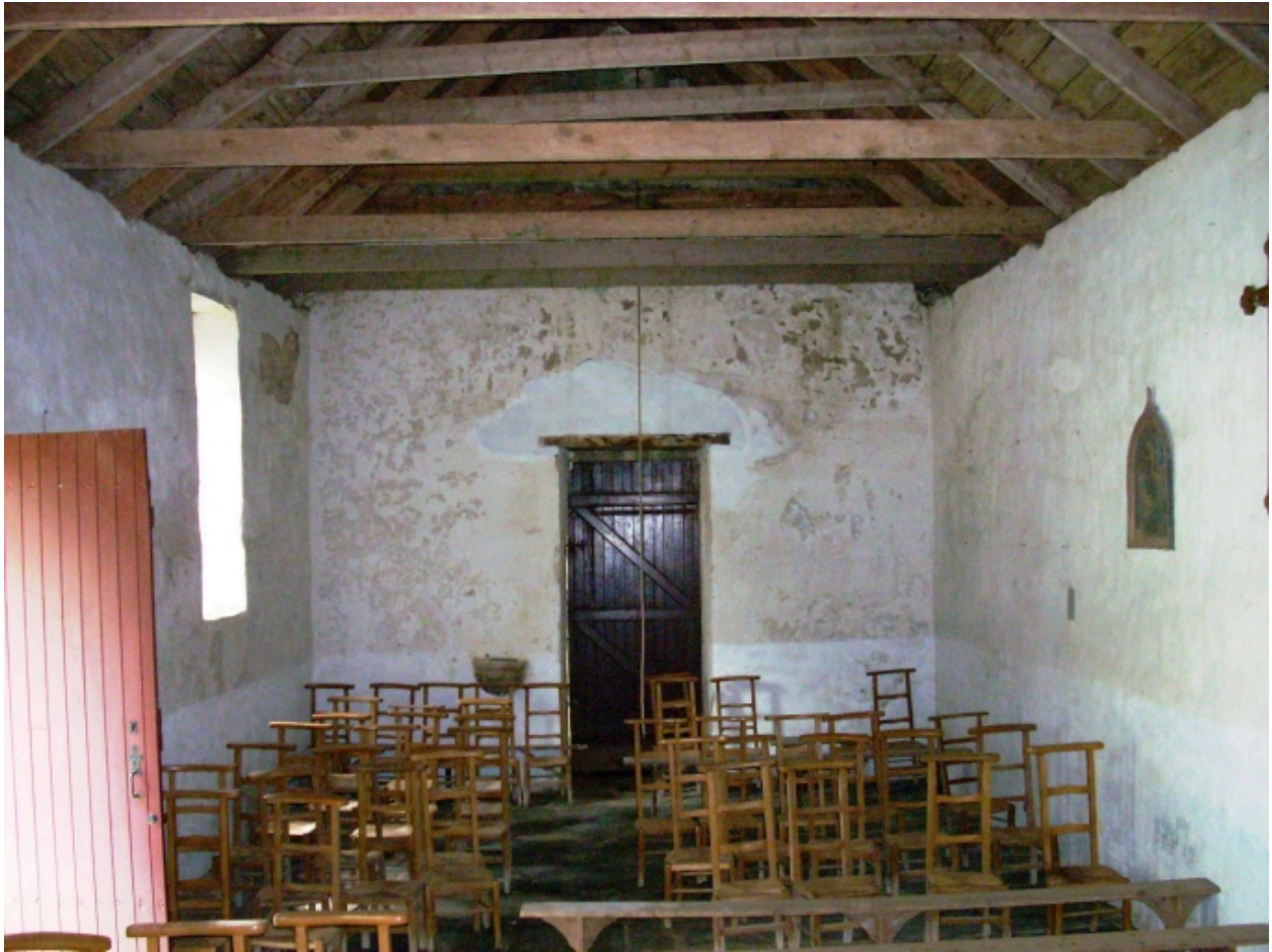
Saint-Sauveur, chapelle Saint-Yves : vue axiale ouest
