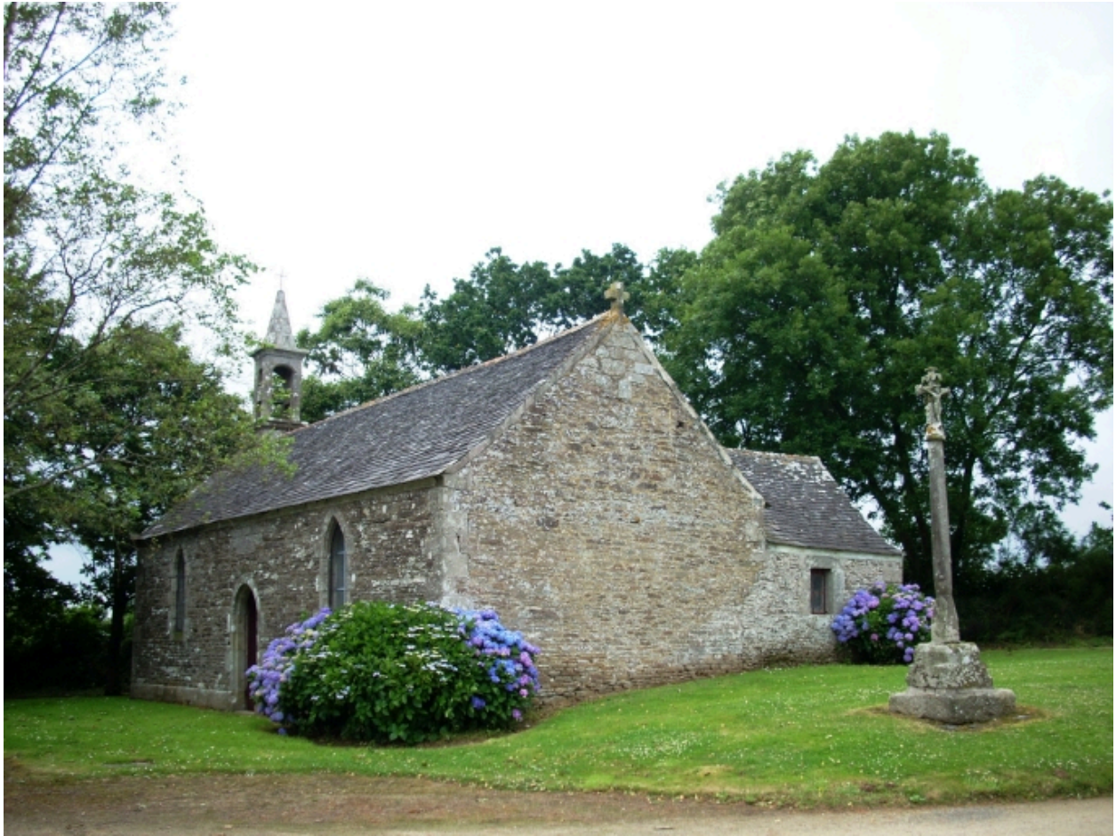
Saint-Sauveur, chapelle Saint-Yves : vue générale sud-est
