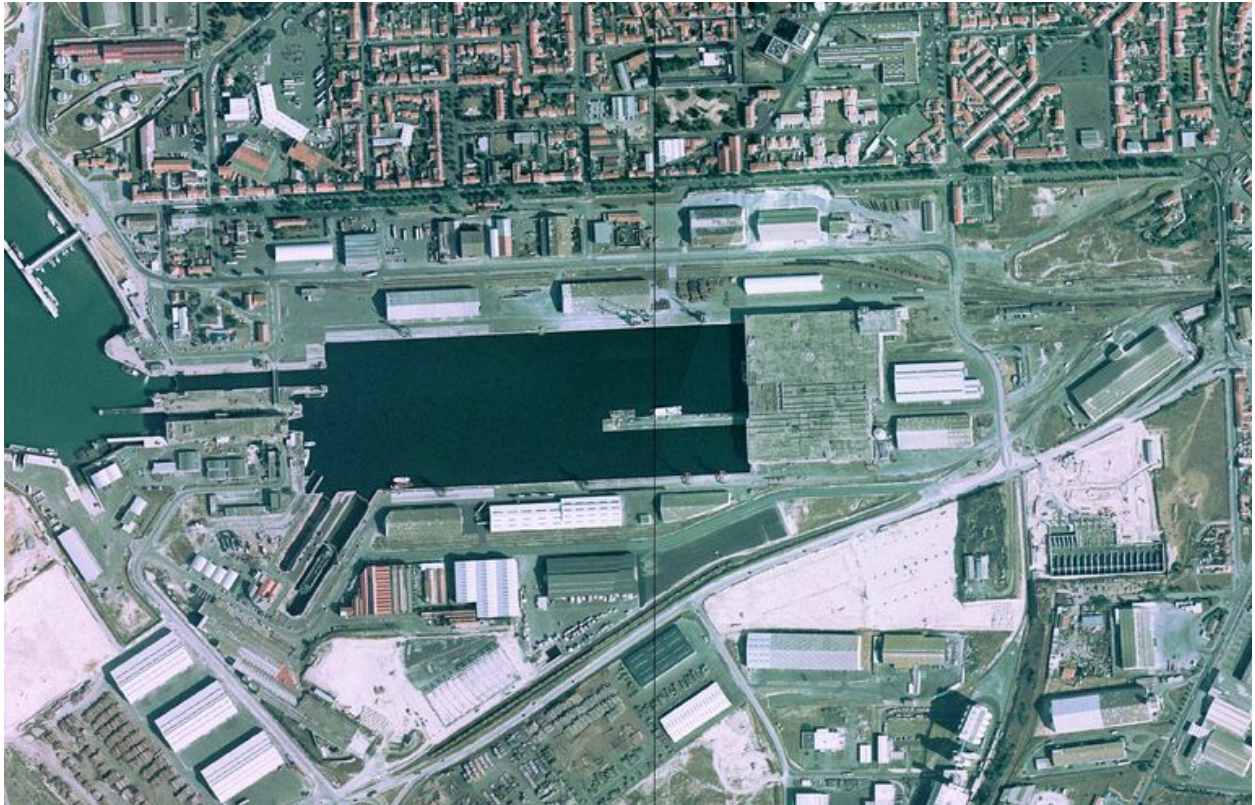
Vue aérienne verticale de la base de sous-marins de La Rochelle La Pallice (orthophotographies littorales)
