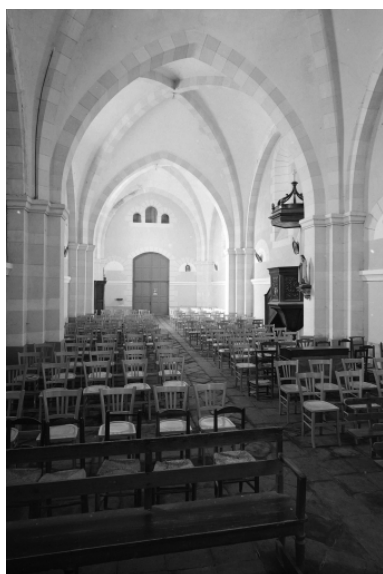
Intérieur, nef : vue générale vers l'ouest. Phot. Guy Artur IVR53_19703500150V
