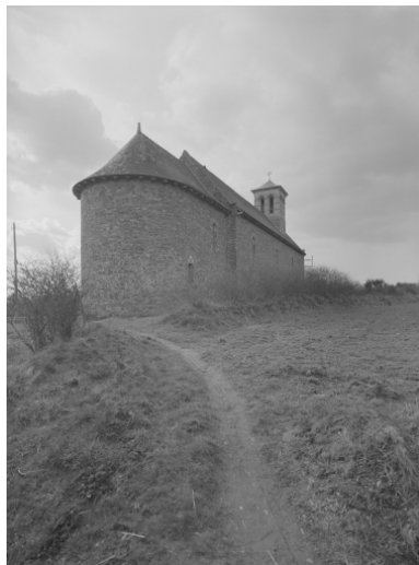
Elévation Nord-Est : vue générale Phot. Guy Artur IVR53_19703500147V
