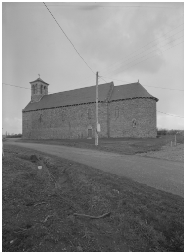
Elévation Sud : vue générale Phot. Guy Artur IVR53_19703500148V
