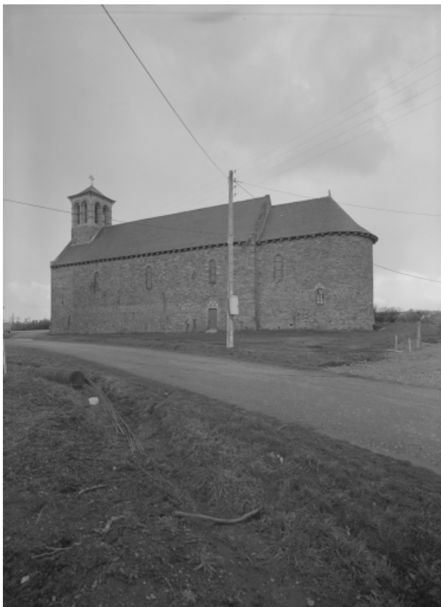
Elévation Sud : vue générale
