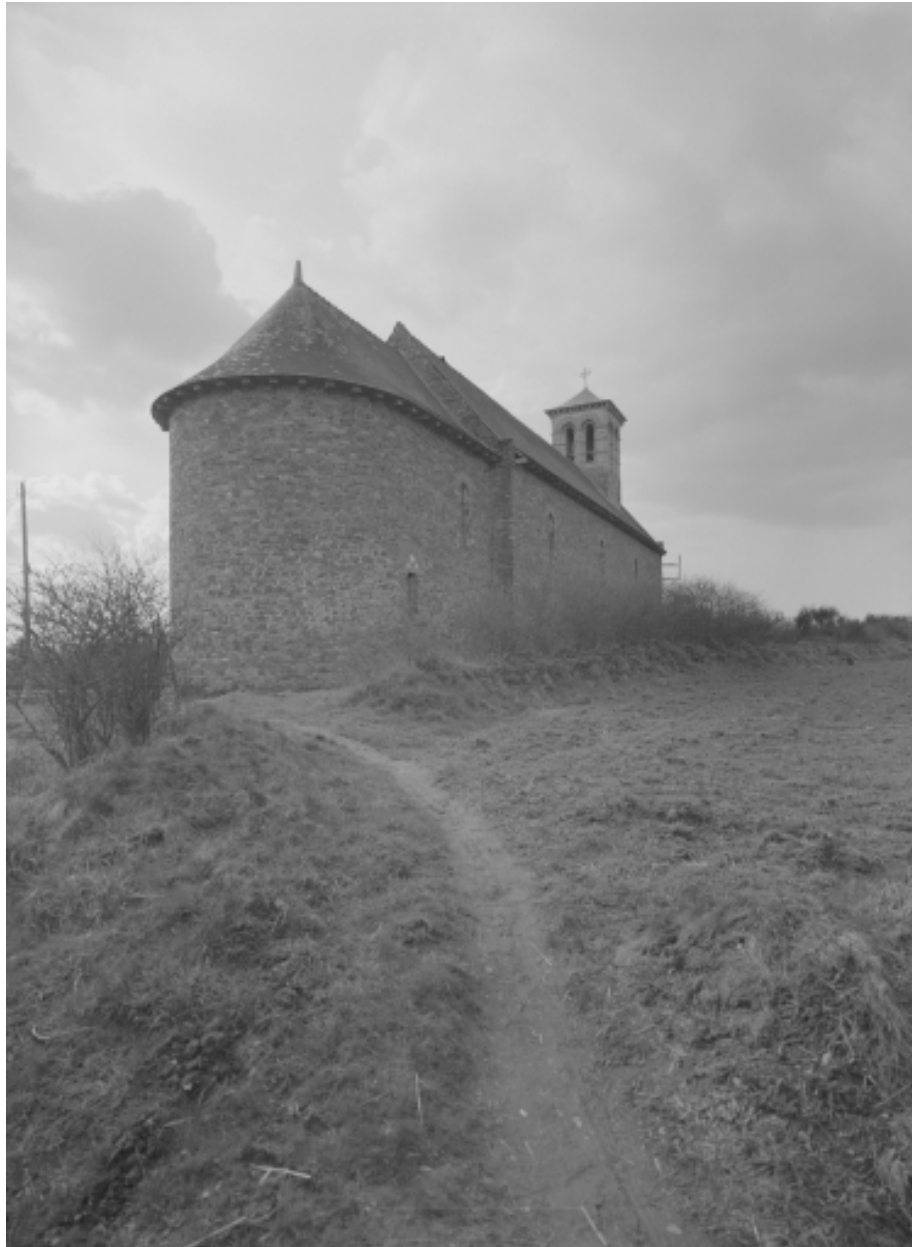
Elévation Nord-Est : vue générale
