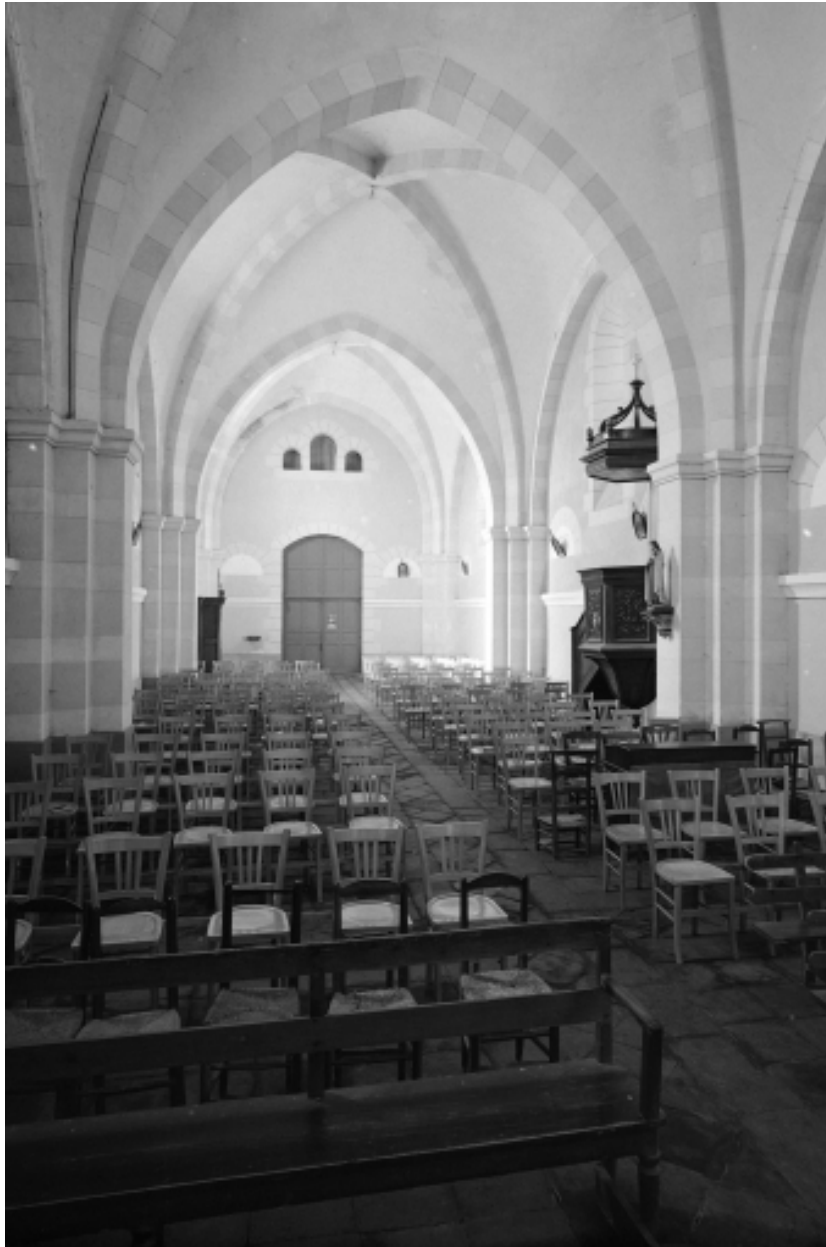
Intérieur, nef : vue générale vers l'ouest.
