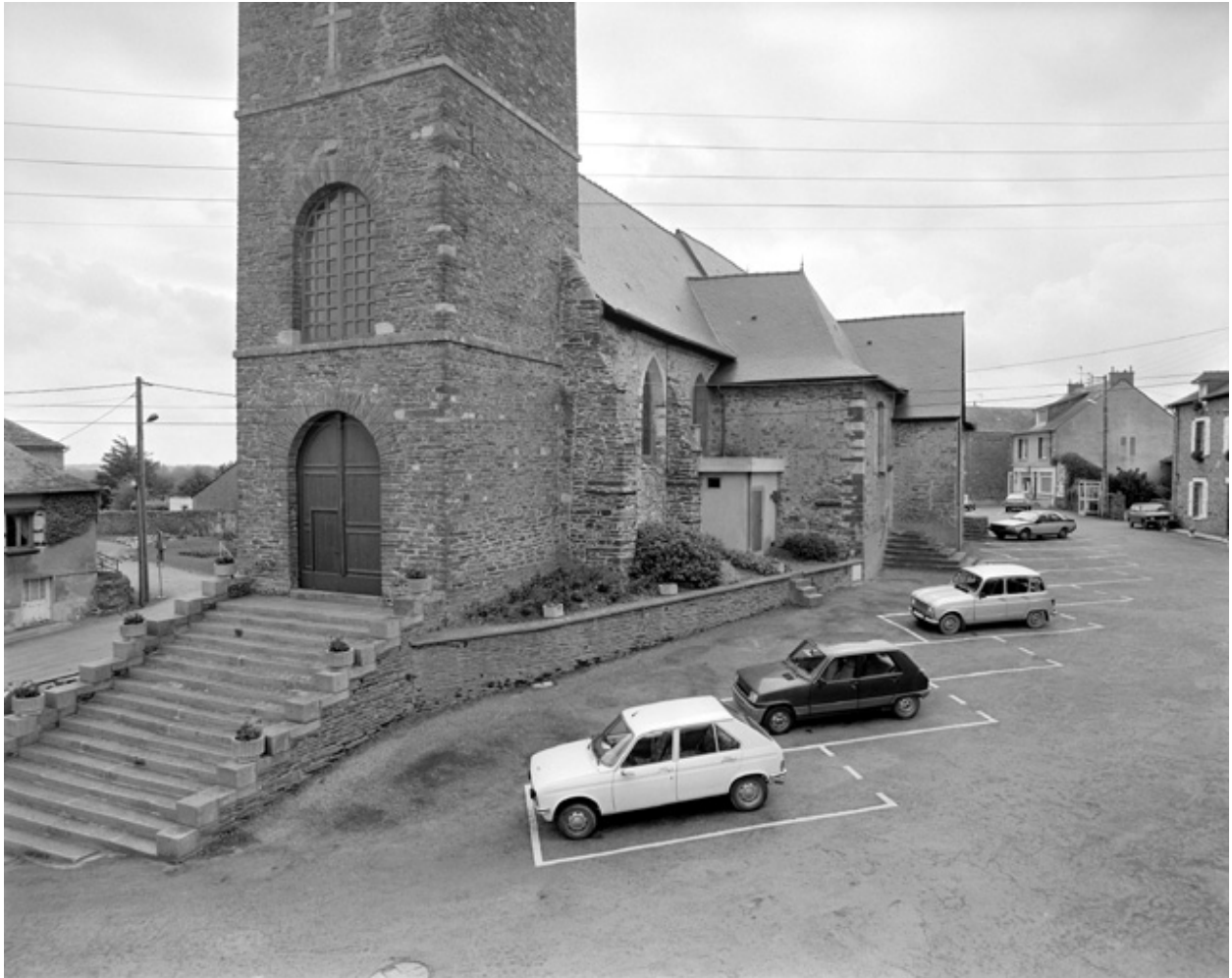
Elévation Sud-Ouest : vue générale
