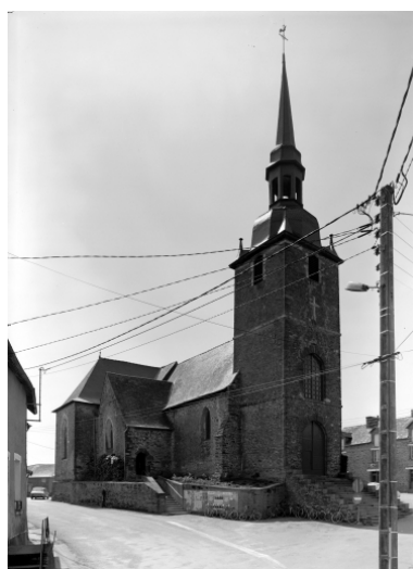
Elévation Nord-Ouest : vue générale Phot. Guy Artur, Phot. Norbert Lambart IVR53_19843501263V
