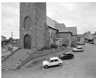
Elévation Sud-Ouest : vue générale Phot. Guy Artur, Phot. Norbert Lambart IVR53_19943500903X
