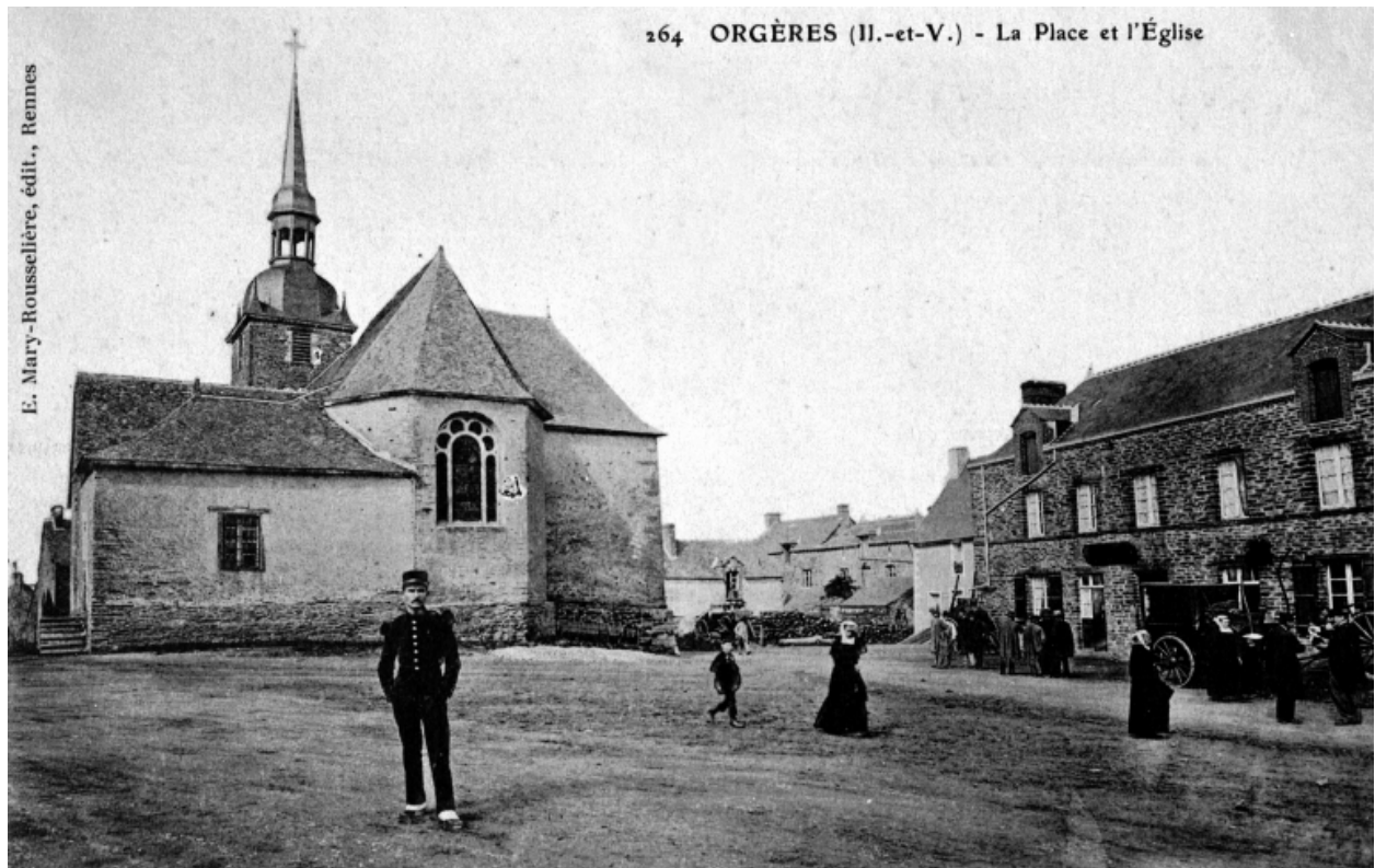
Elévation Est : vue générale (Carte postale ancienne, AD35 : 6Fi)
