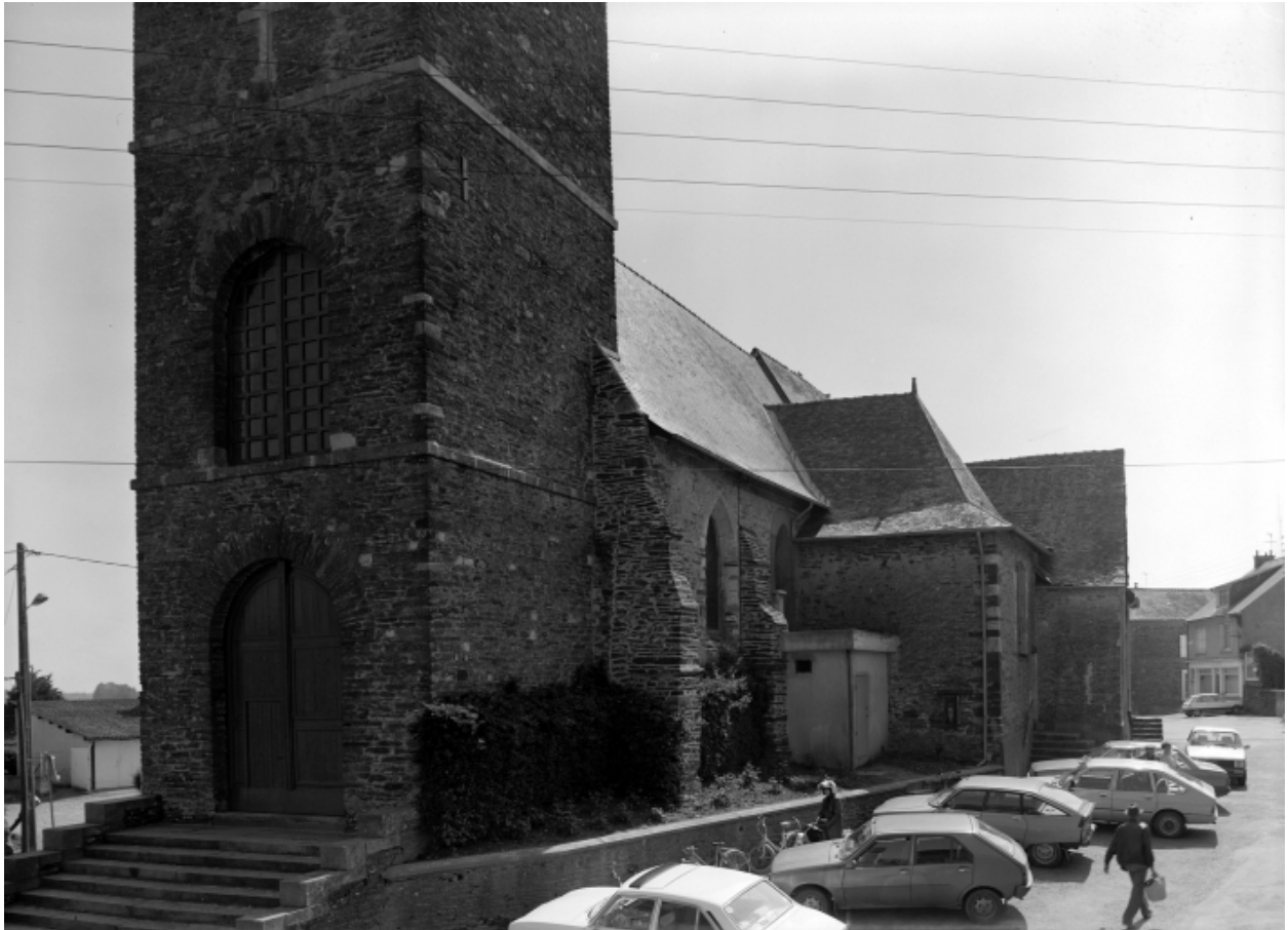
Elévation Sud-Ouest : vue générale
