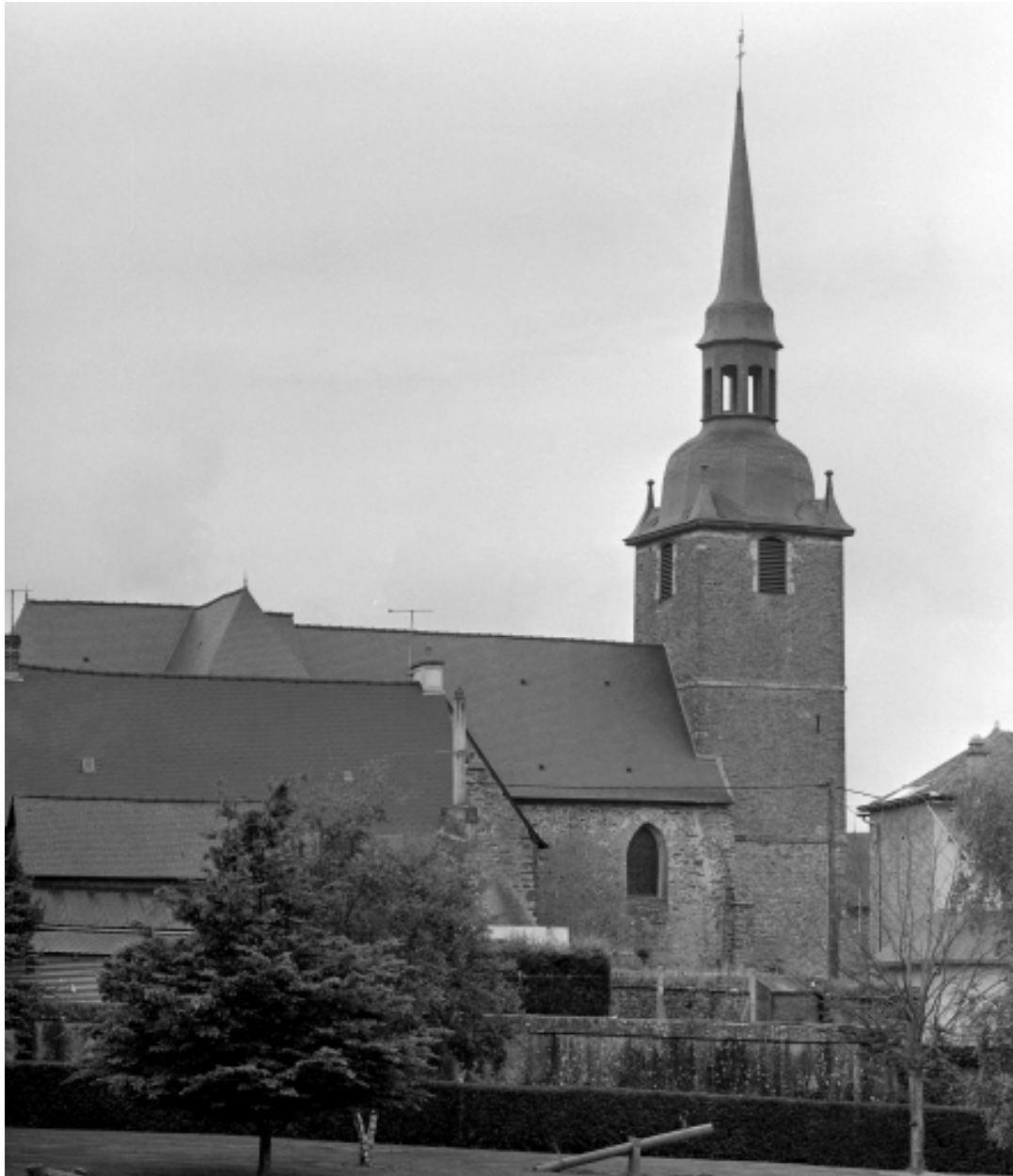
Elévation Nord, partie Ouest : vue générale
