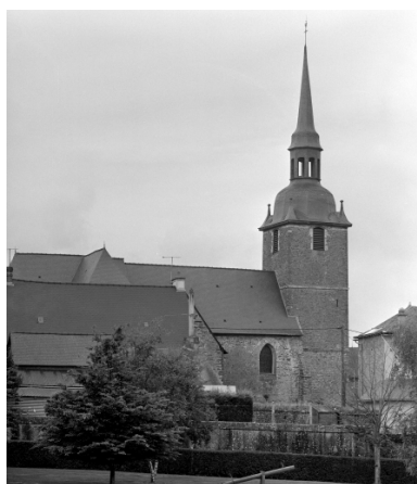
Elévation Nord, partie Ouest : vue générale Phot. Guy Artur, Phot. Norbert Lambart IVR53_19943500904X
