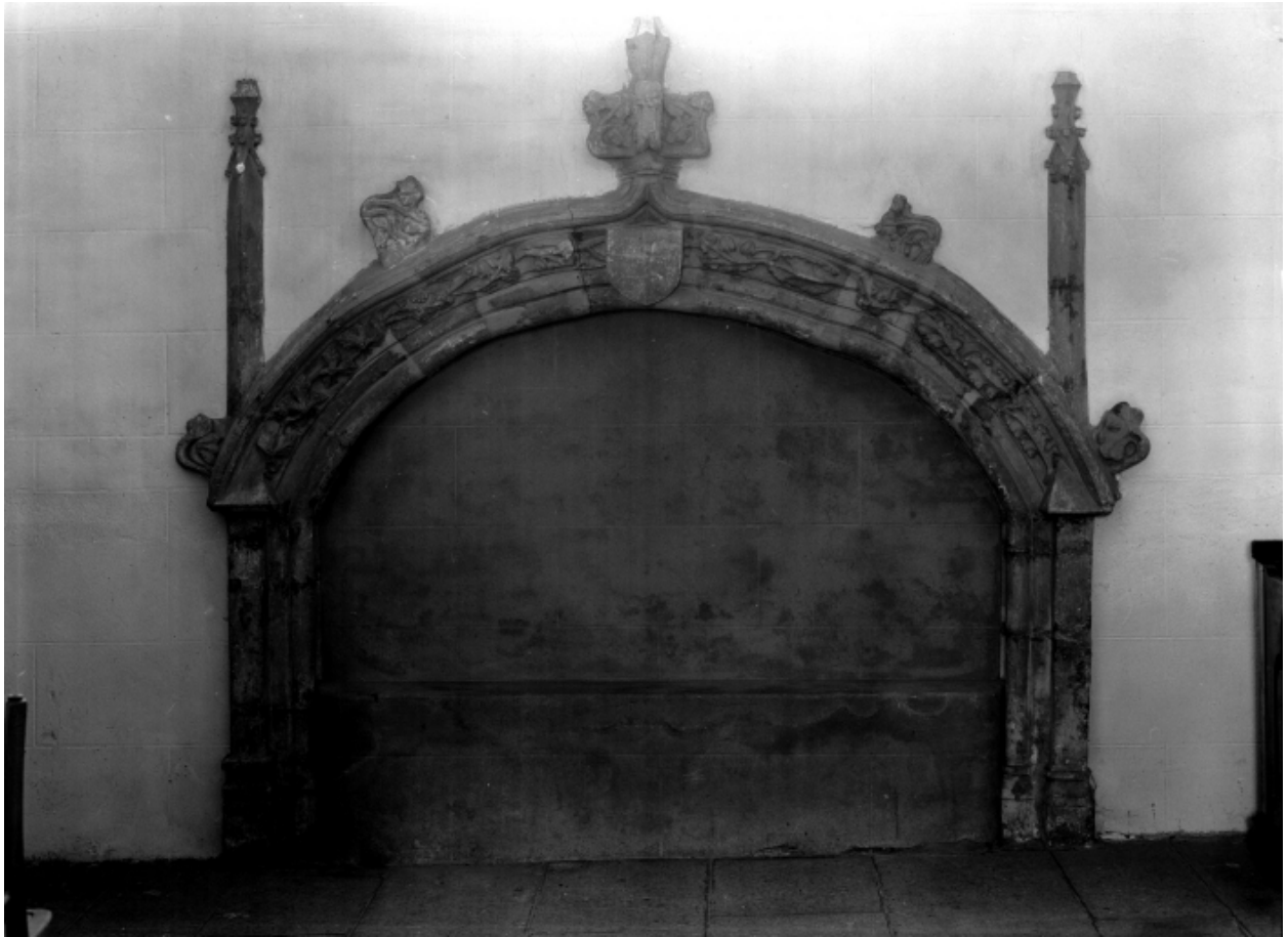
Chapelle nord, enfeu, vue générale.
