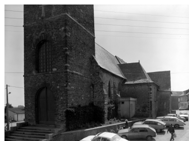
Elévation Sud-Ouest : vue générale Phot. Guy Artur, Phot. Norbert Lambart IVR53_19843501262V
