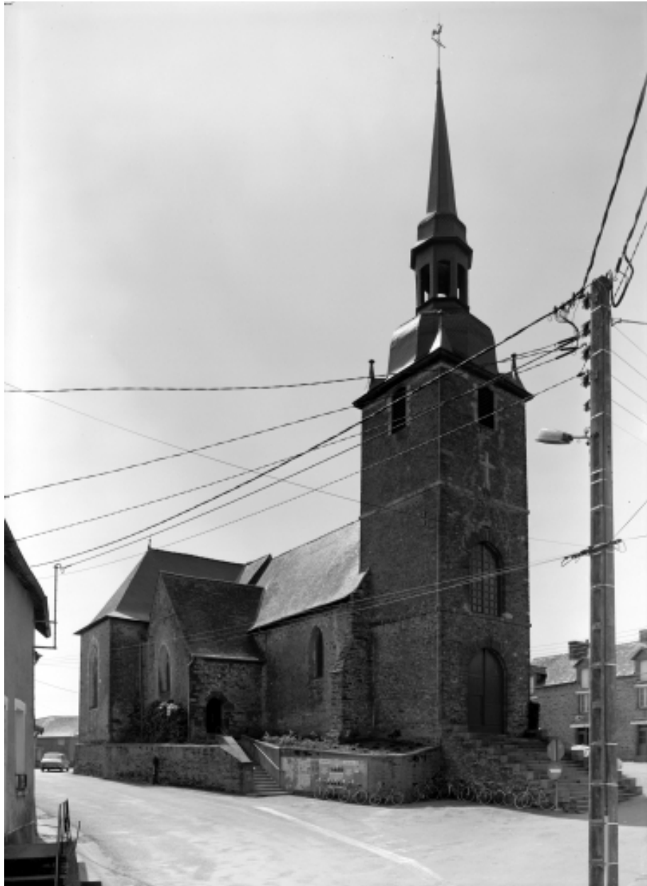
Elévation Nord-Ouest : vue générale
