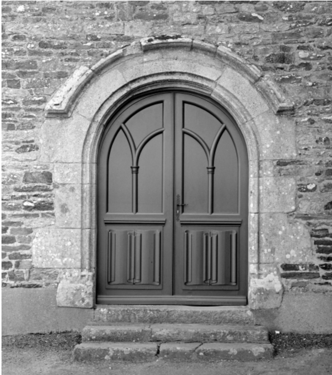
Elévation Sud, porte : vue générale
