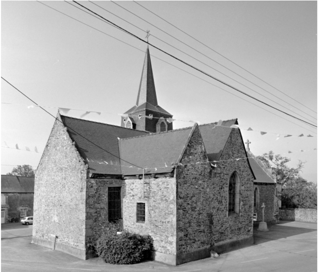
Elévation Sud-Ouest : vue générale
