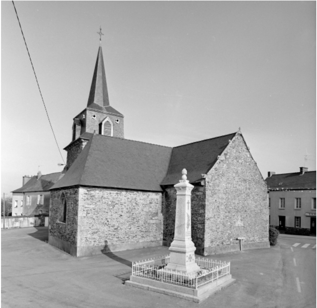
Elévation Est : vue générale
