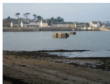
Vue des caissons Phot. Guillaume Marie IVR53_20062908568NUCA
