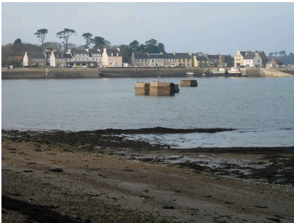
Vue des caissons
