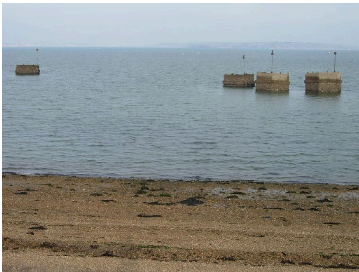
Vue générale des caissons de l'anse du Fret
