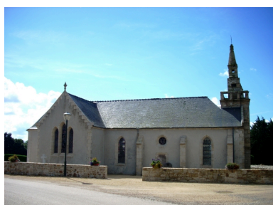
Bolazec, église paroissiale Notre-Dame et Saint- Guénaël : vue générale nord Phot. Gwénaél Fauchille IVR53_20082906671NUCA
