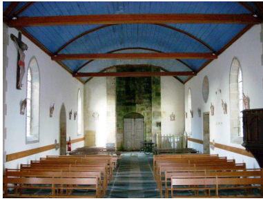
Bolazec, église paroissiale Notre-Dame et Saint- Guénaël : vue axiale ouest Phot. Gwénaél Fauchille IVR53_20082906674NUCA
