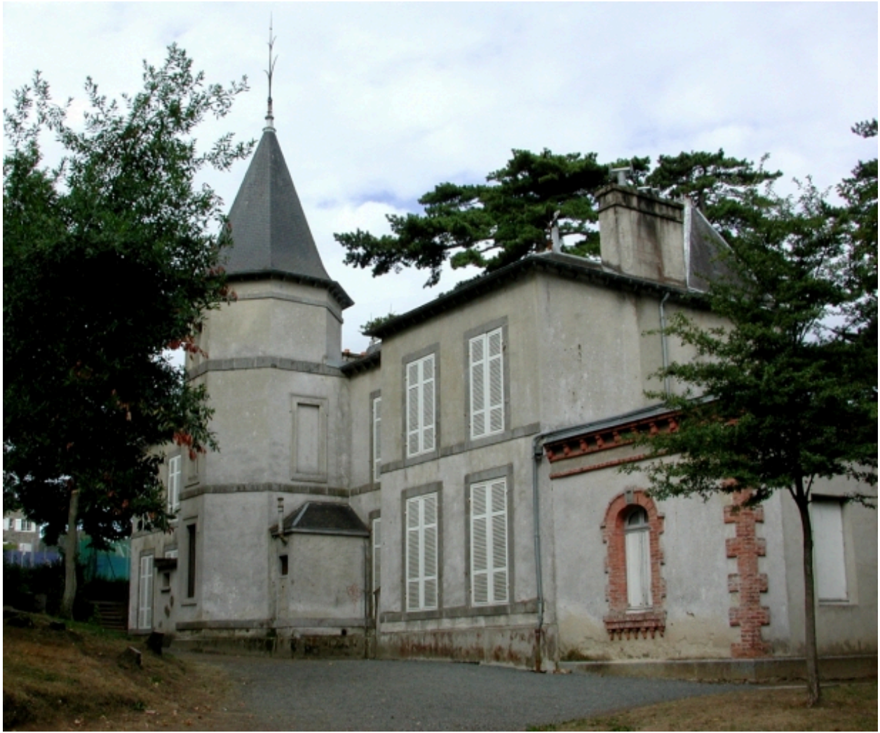
Vue générale de la façade postérieure
