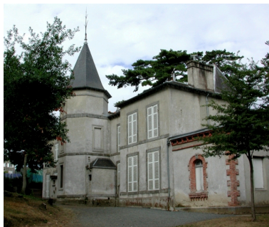
Vue générale de la façade postérieure
