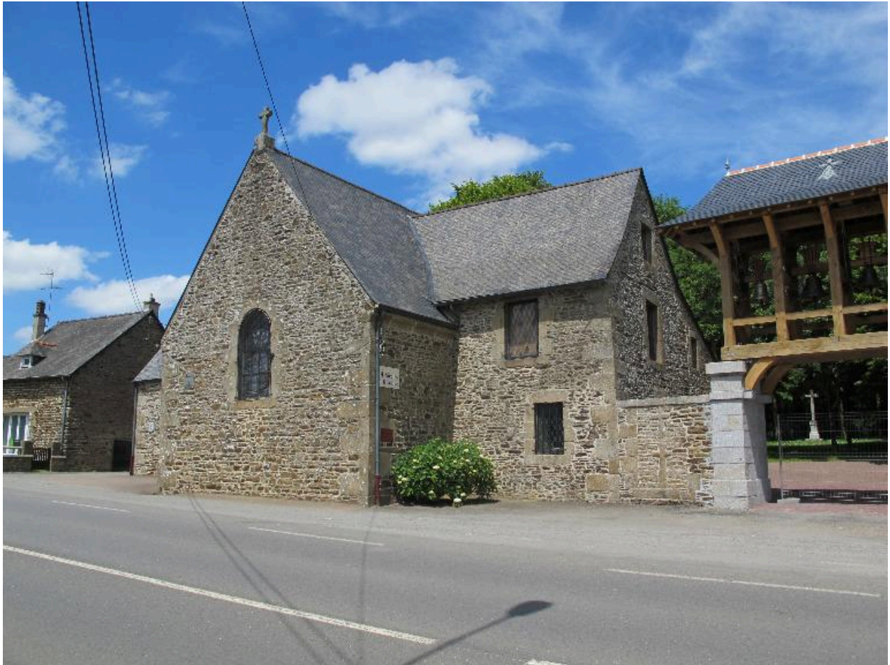
Vue générale : côté Sud-Est (état actuel)
