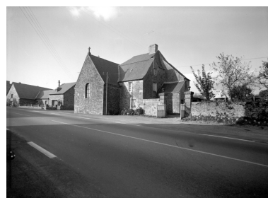
Élévation sud-est : vue générale
