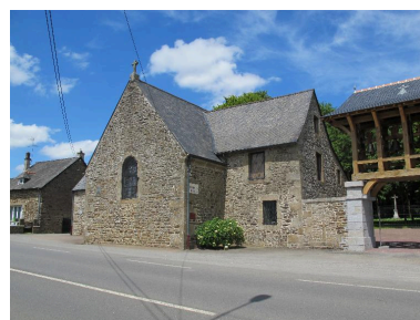
Vue générale : côté Sud-Est (état actuel) Phot. Frédéric Déan IVR53_20133520347NUCA
