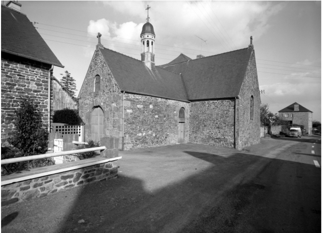
Elévation Sud-Ouest : vue générale
