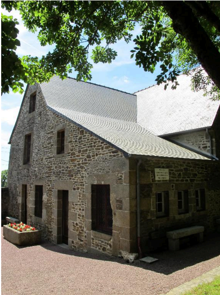
Construction adossée au chevet de la chapelle : actuelle sacristie
