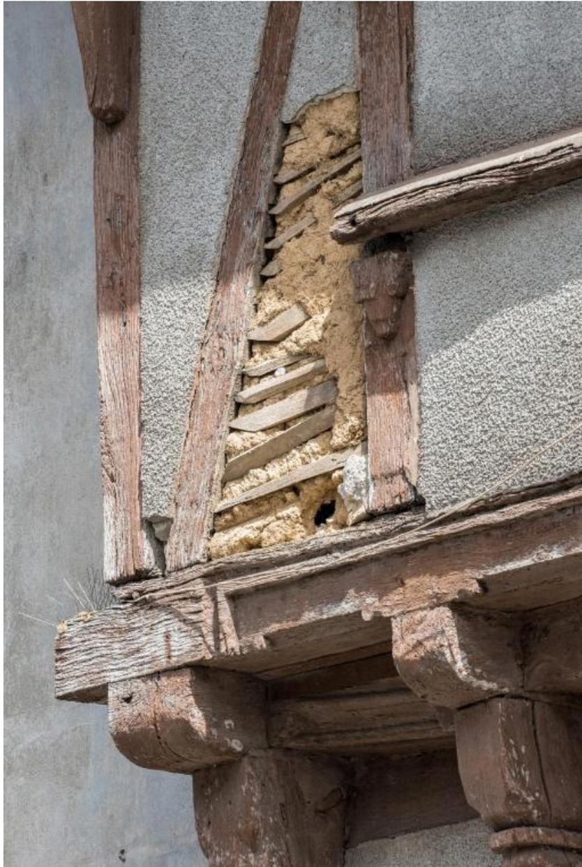
Torchis apparent sous l'enduit ciment.
