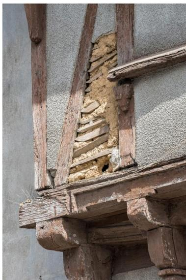
Torchis apparent sous l'enduit ciment.
