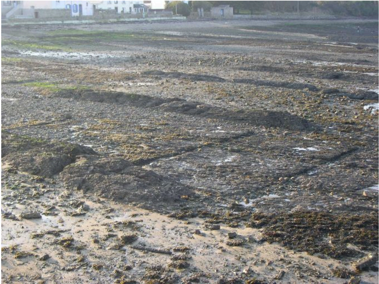
Vue générale du bassin de décantation
