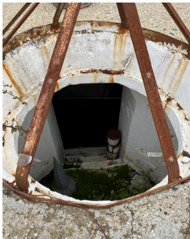
Poste d'observation dit Tobrouk, rue de Paris - vue intérieure depuis la tourelle Phot. Pierre Laurent Constantin IVR53_20225605752NUCA
