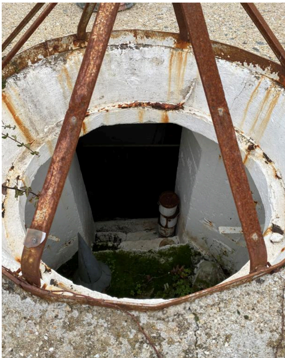
Poste d'observation dit Tobrouk, rue de Paris - vue intérieur depuis la tourelle
