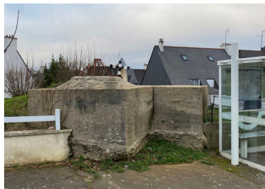
Poste d'observation dit Tobrouk, rue de Paris - Vue du poste d'observation dit Tobrouk Phot. Pierre Laurent Constantin IVR53_20225605751NUCA
