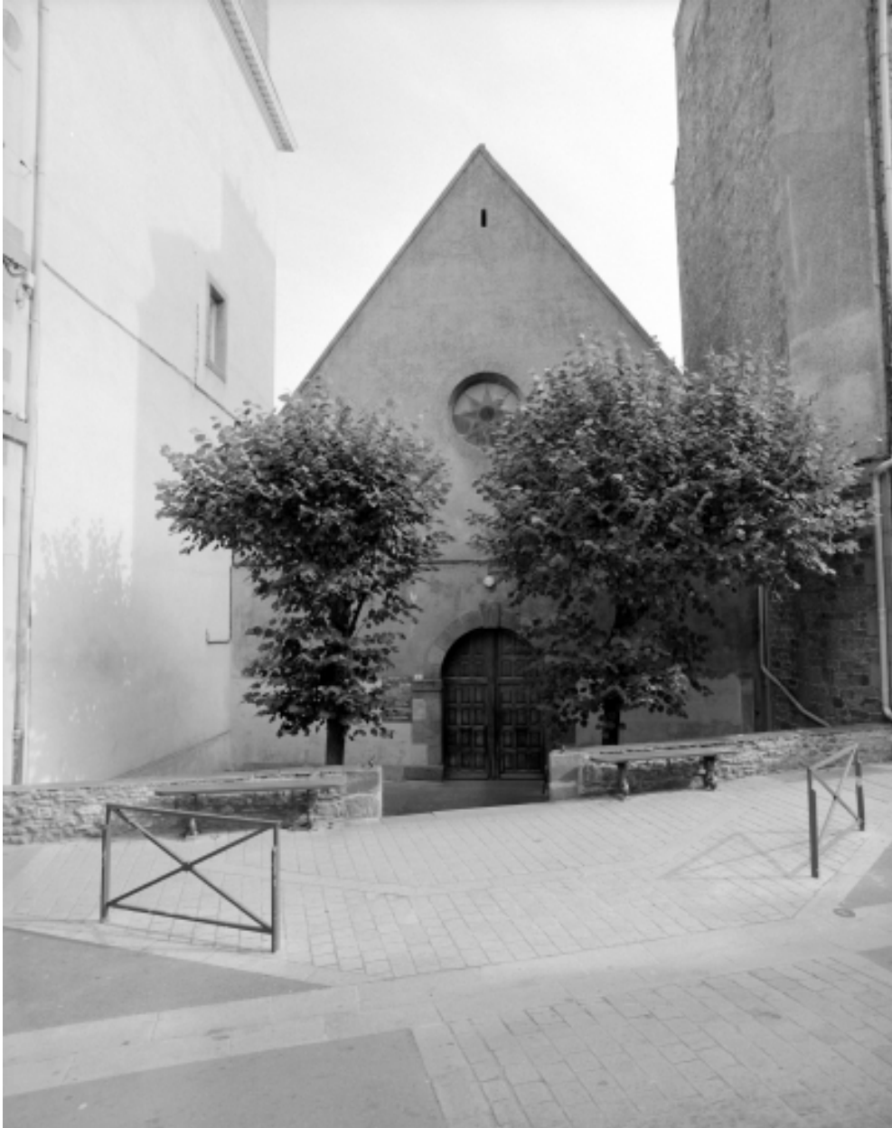
Elévation Ouest : vue générale
