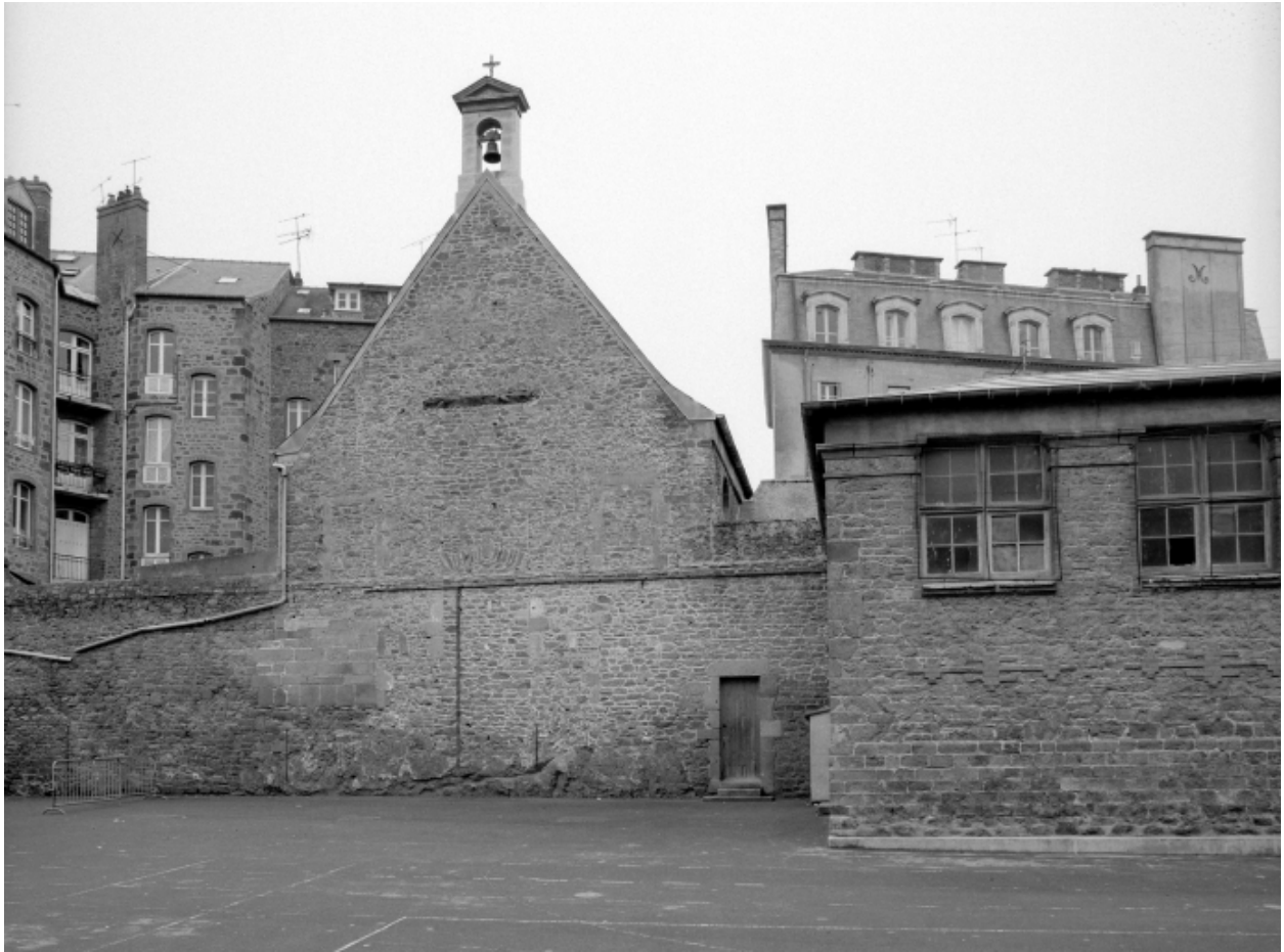
Elévation Est : vue générale
