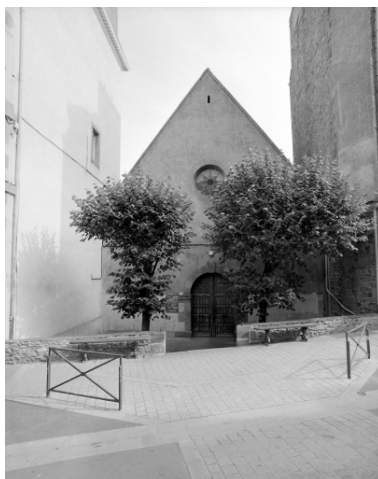
Elévation Ouest : vue générale Phot. Bernard Bègne, Phot. M. Loyon IVR53_19923500784X
