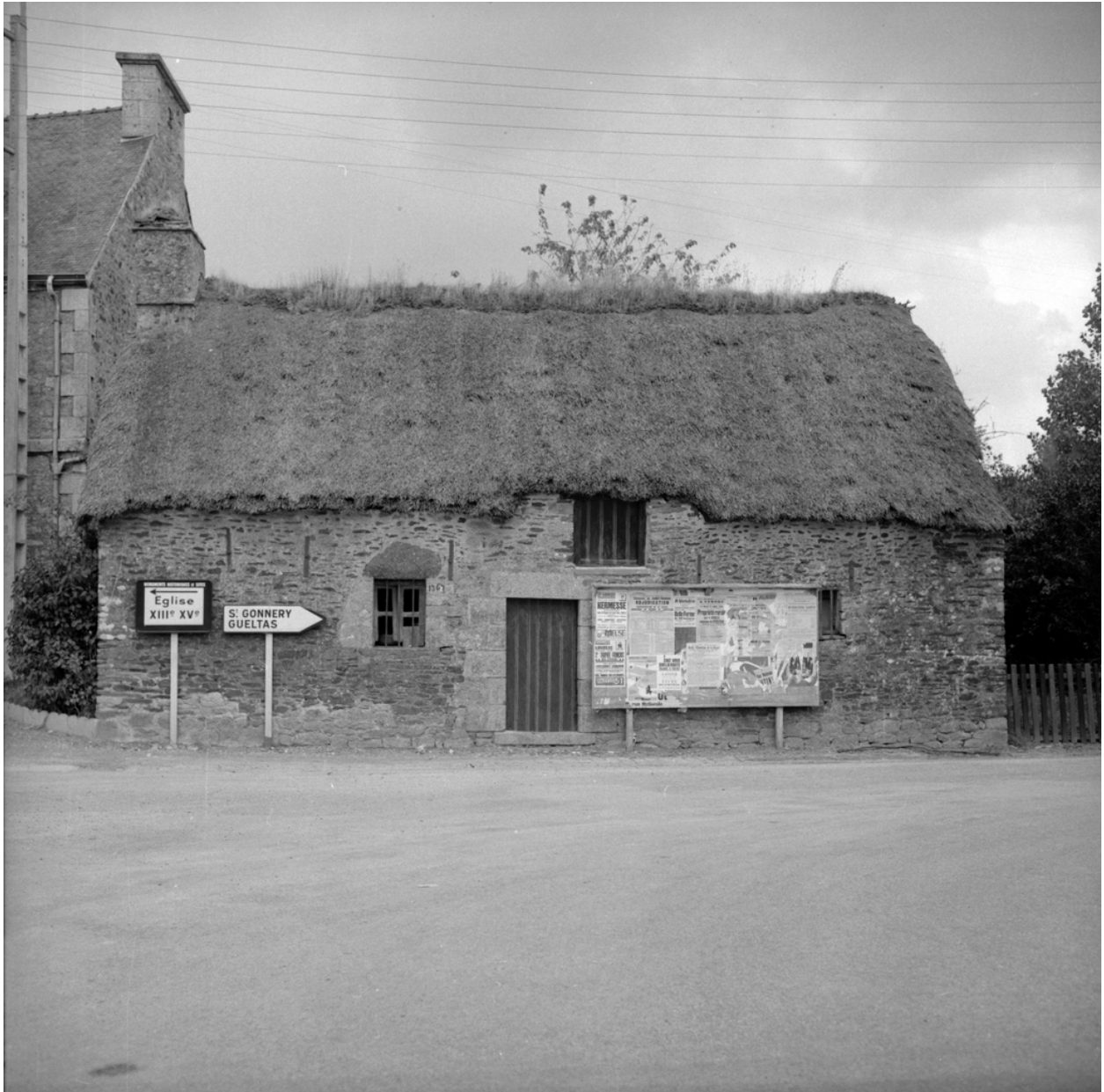
Quatrième maison (détruite), rue de l'Egalité, (cad 1847-N4-parcelle545 ; cad 1974-AB-parcelle116), élévation sud.
