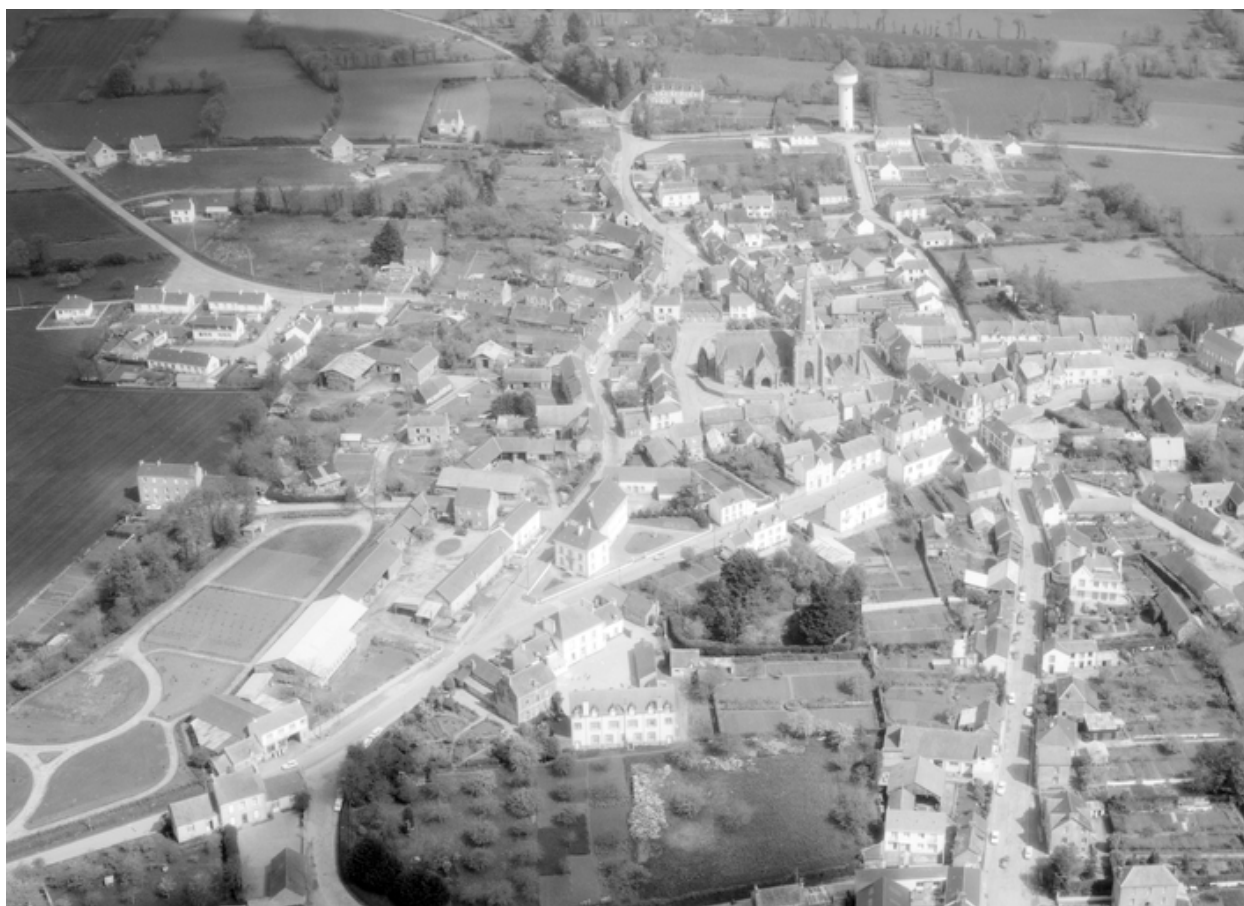
Vue de situation sud.
