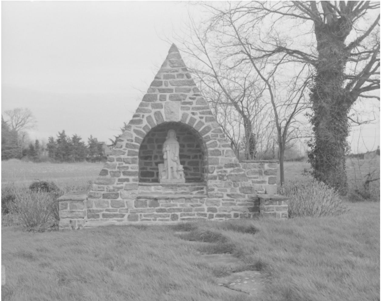
Vestiges de la chapelle aménagés en oratoire : vue générale
