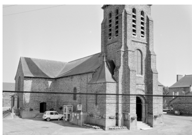
Elévation Ouest : vue générale. Phot. Auteur inconnu IVR53_19943501435X
