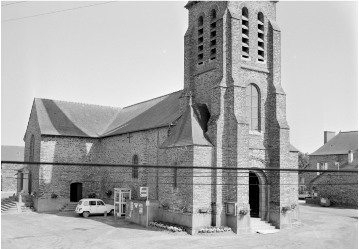
Elévation Ouest : vue générale.
