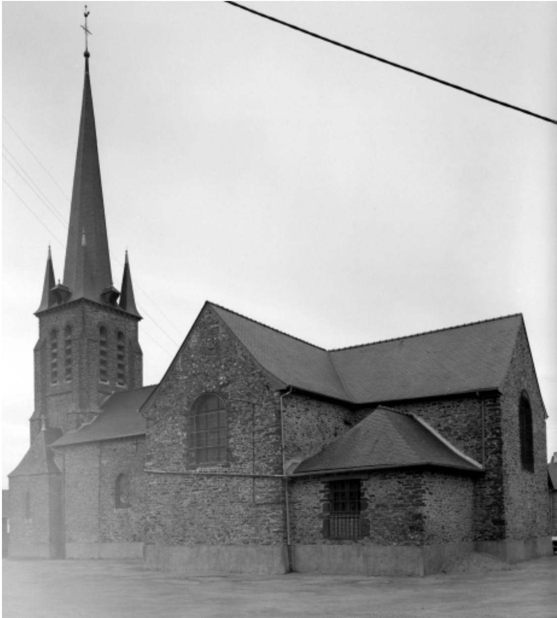
Vue générale sud-est.
