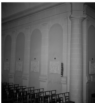
Nef, élévation intérieure, côté nord, vue générale. Phot. Guy Artur, Phot. Norbert Lambart IVR53_19823501360X
