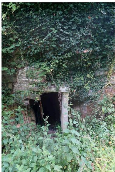
Vue de la poterne aménagée dans la tour ouest du châtelet. En mauvais état, sa maçonnerie est étayée par un poteau en béton armé
