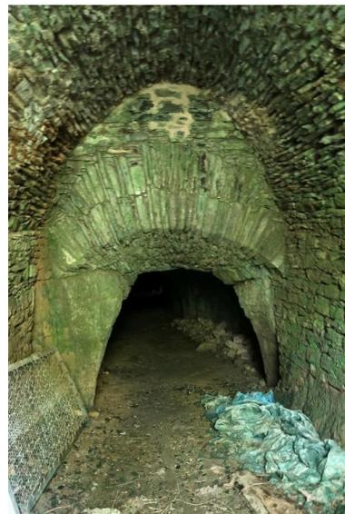
Vue de l'entrée du souterrain : arc en berceau s'appuyant sur le rocher et soutenant la voûte
