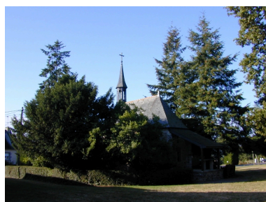
La longère est et le chevet : vue générale nord-est Phot. Xavier Gilbert IVR53_20003514542NUCA
