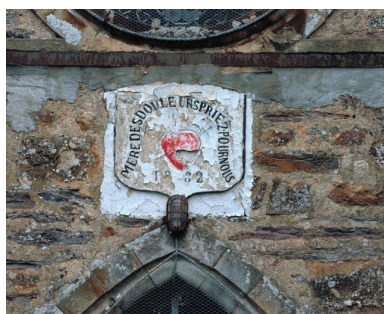
Façade sud, pierre de calcaire portant date et dédicace : détail Phot. Guy Artur, Phot. Norbert Lambart IVR53_20003502594XA
