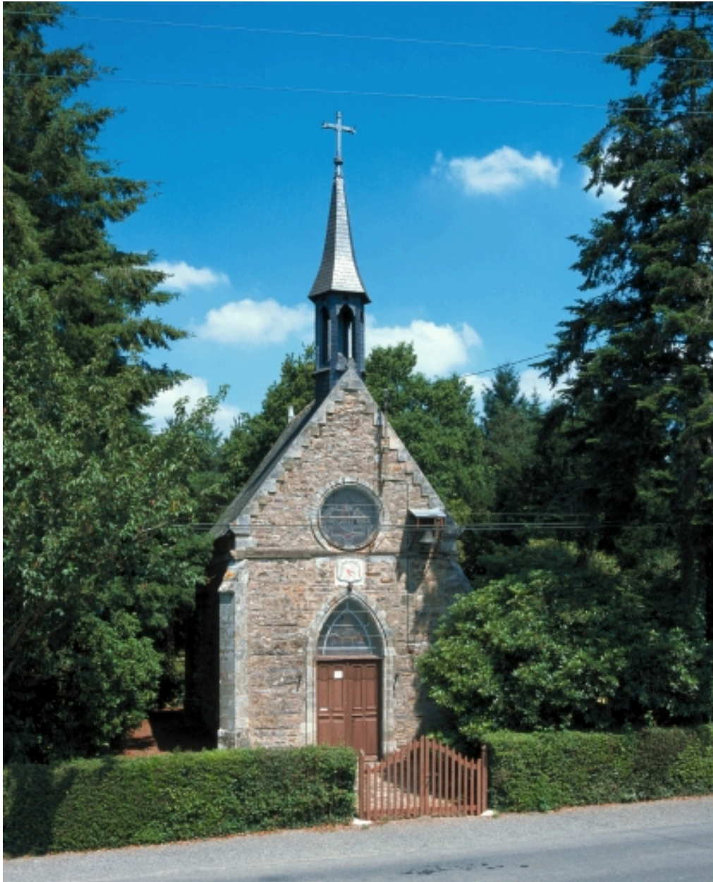
Façade : vue générale sud
