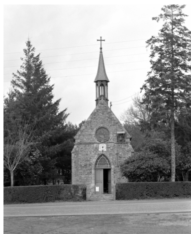
Façade : vue générale sud Phot. Guy Artur, Phot. Norbert Lambart IVR53_19933500072X
