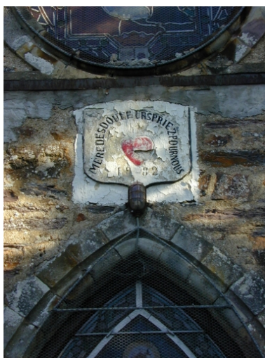
Façade sud, pierre de calcaire portant date et dédicace : détail Phot. Xavier Gilbert IVR53_20003514890NUCA
