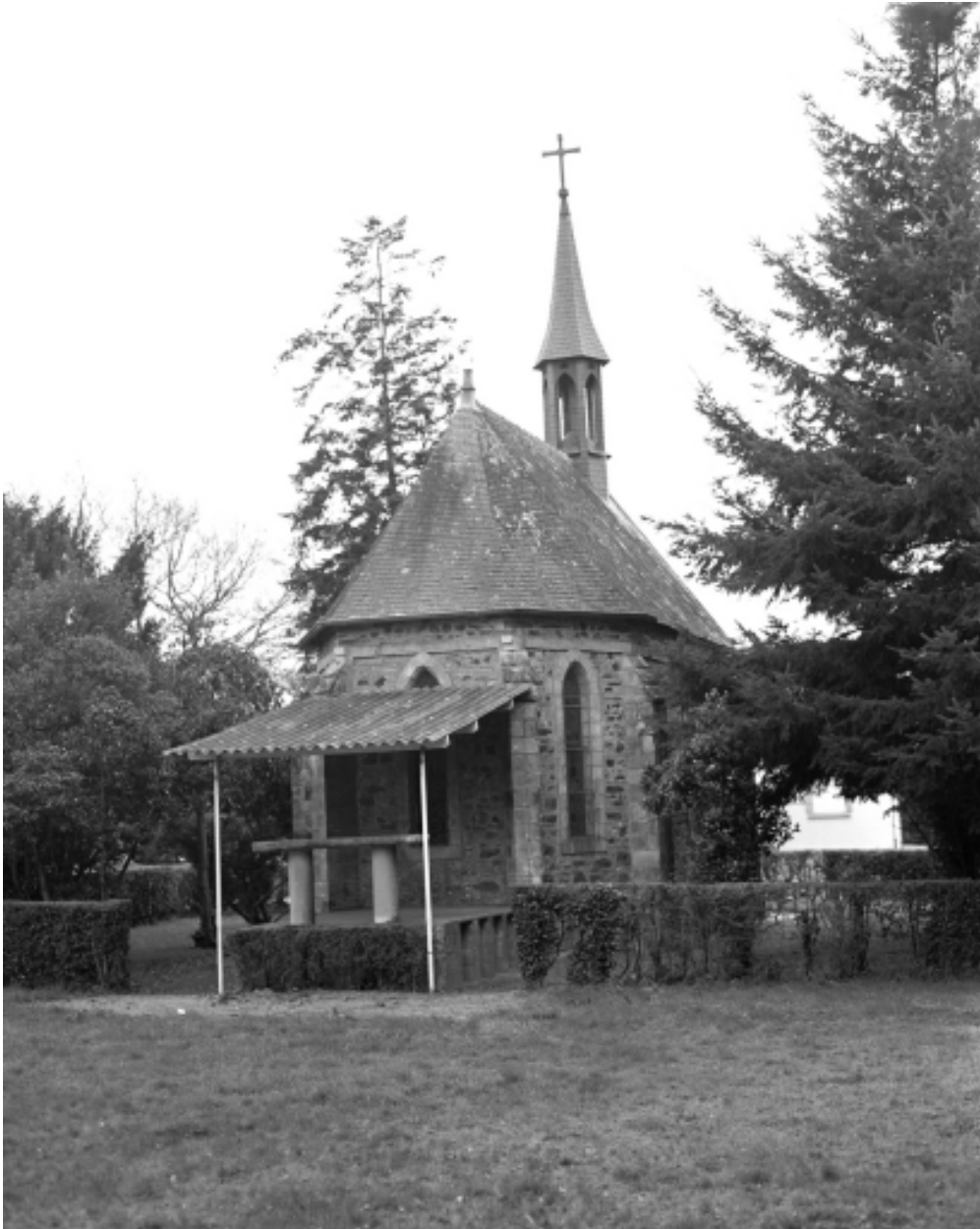
Le chevet avec son autel de plein air : vue générale nord-ouest
