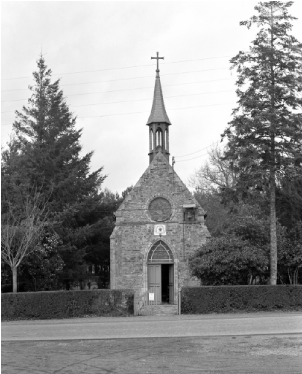
Façade : vue générale sud
