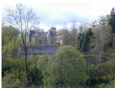
Vue de situation depuis le nord du village Phot. Anne-Cécile Turquety IVR53_20023510265NUCA
