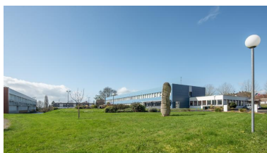
Bâtiment E, administration externat, vue d'ensemble prise de l'est. Au premier plan, la sculpture d'Héliel Pellerin et Lise Mazo (1% artistique), à gauche, façade des ateliers. Albert Hec et Roger Besnard, architectes, 1969. Phot. Delia Gaulin-Crespel IVR53_20203500371NUCA
