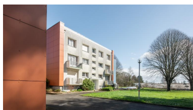
Bâtiment H, logements : façade sud de l'aile ouest. Albert Hec et Roger Besnard, architectes, 1969. Phot. Delia Gaulin-Crespel IVR53_20203500373NUCA
