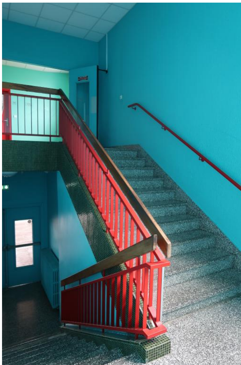
Bâtiment E, administration - externat : cage d'escalier.
