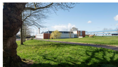
Vue d'ensemble prise de l'est : au premier plan, bâtiment G, ateliers, à l'arrière plan, bâtiment E, administration - internat. Albert Hec et Roger Besnard, architectes, 1969. Phot. Delia Gaulin-Crespel IVR53_20203500375NUCA
