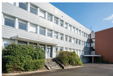
Bâtiment F : internat, aujourd'hui internat et externat, ancienne entrée du foyer des internes et angle entre les barres mitoyennes décalées. Albert Hec et Roger Besnard, architectes, 1969. Phot. Delia Gaulin-Crespel IVR53_20203500370NUCA
