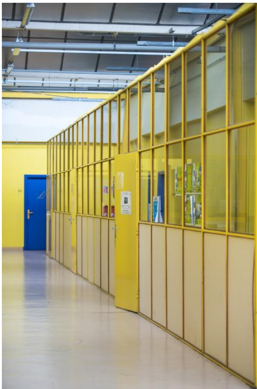
Bâtiment G, ateliers : cloisons des salles de classe installées sur le pourtour.
