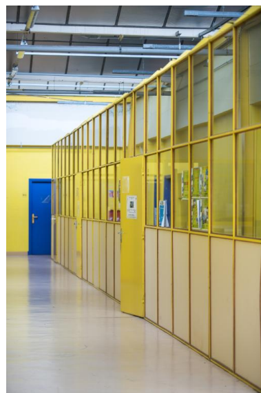
Bâtiment G, ateliers : cloisons des salles de classe installées sur le pourtour. Phot. Delia Gaulin-Crespel IVR53_20203500358NUCA
