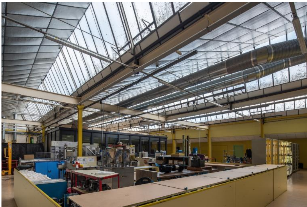
Bâtiment G, Ateliers sous sheds, vue intérieure.
