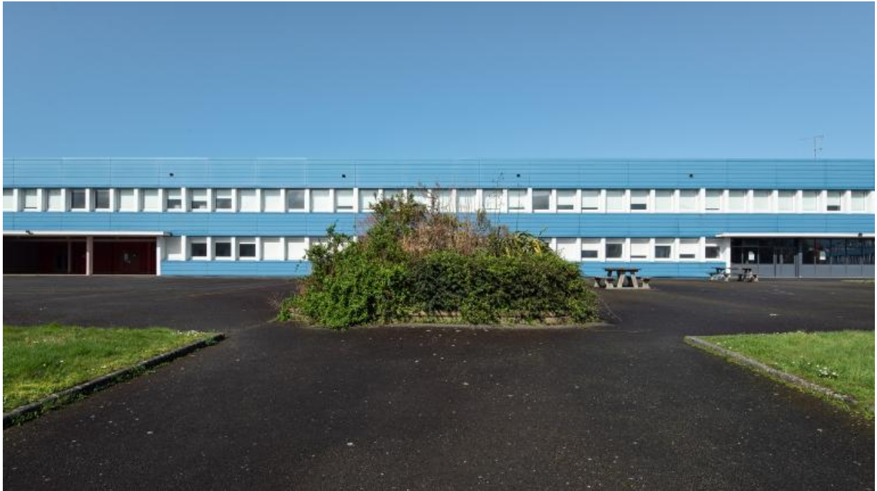
Bâtiment E, externat : façade sud-est. Albert Hec et Roger Besnard, architectes, 1969. Noter les deux préaux. Celui de gauche est toujours ouvert.
