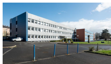
Bâtiment F, internat, aujourd'hui internat et externat : vue d'ensemble prise de l'ouest. Albert Hec et Roger Besnard, architectes, 1969. Phot. Delia Gaulin-Crespel IVR53_20203500366NUCA
