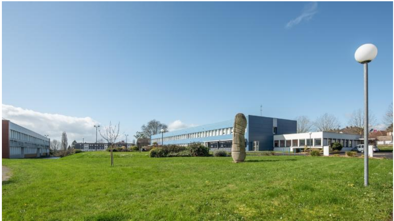
Bâtiment E, administration externat, vue d'ensemble prise de l'est. Au premier plan, la sculpture d'Héliel Pellerin et Lise Mazo (1% artistique), à gauche, façade des ateliers. Albert Hec et Roger Besnard, architectes, 1969.
