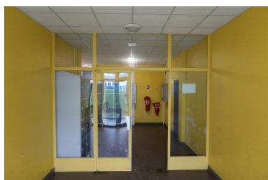
Bâtiment G, ateliers : menuiseries intérieures d'origine. Phot. Thierry Goyet IVR53_20203505084NUCA
