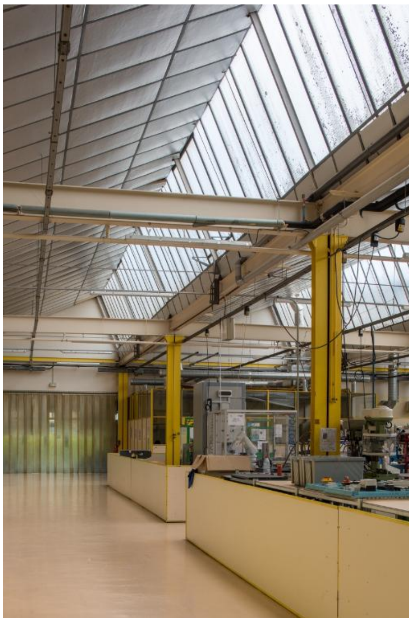
Bâtiment G, ateliers : structure métallique et sheds.
