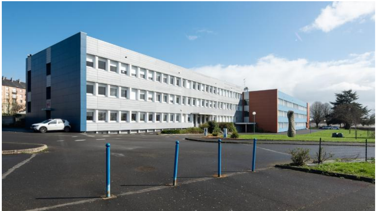
Bâtiment F, internat, aujourd'hui internat et externat : vue d'ensemble prise de l'ouest. Albert Hec et Roger Besnard, architectes, 1969.
