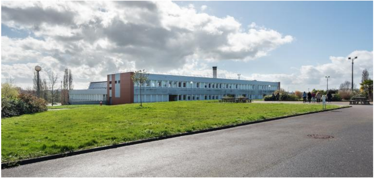
Bâtiment G, ateliers, vue d'ensemble prise du nord. Albert Hec et Roger Besnard, architectes, 1969.
