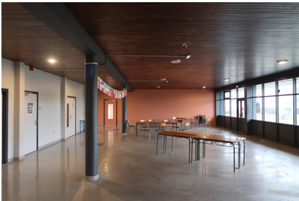
Bâtiment E, administration - externat : ancien préau transformé en hall.
