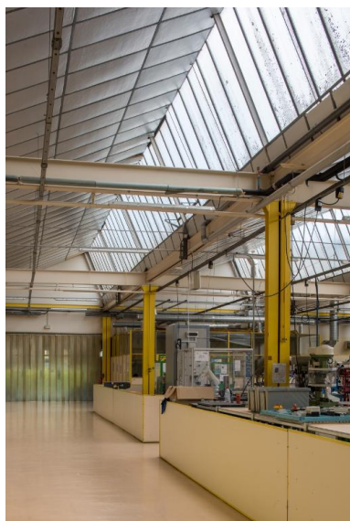
Bâtiment G, ateliers : structure métallique et sheds. Phot. Delia Gaulin-Crespel IVR53_20203500361NUCA
