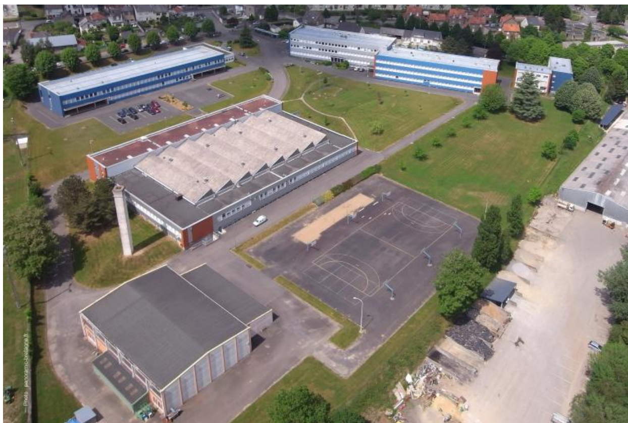
Vue aérienne oblique (2010).
