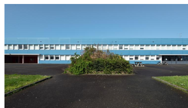
Bâtiment E, externat : façade sud-est. Albert Hec et Roger Besnard, architectes, 1969. Noter les deux préaux. Celui de gauche est toujours ouvert. Phot. Delia Gaulin-Crespel IVR53_20203500365NUCA
