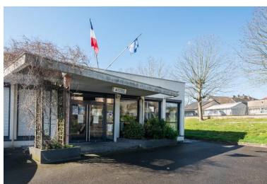
Bâtiment E, externat et administration : façade nord-est de l'administration et de l'accueil. Noter le dessin du auvent, en rupture avec les formes carrées et rectangulaires de l'ensemble du bâti. Albert Hec et Roger Besnard, architectes, 1969. Phot. Delia Gaulin-Crespel IVR53_20203500369NUCA
