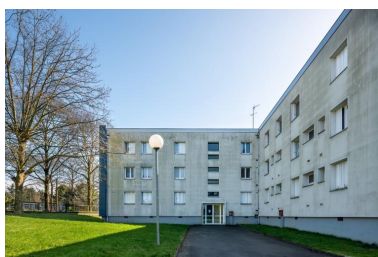
Bâtiment H, logements : façades ouest et nord. Albert Hec et Roger Besnard, architectes, 1969. Phot. Delia Gaulin-Crespel IVR53_20203500374NUCA
