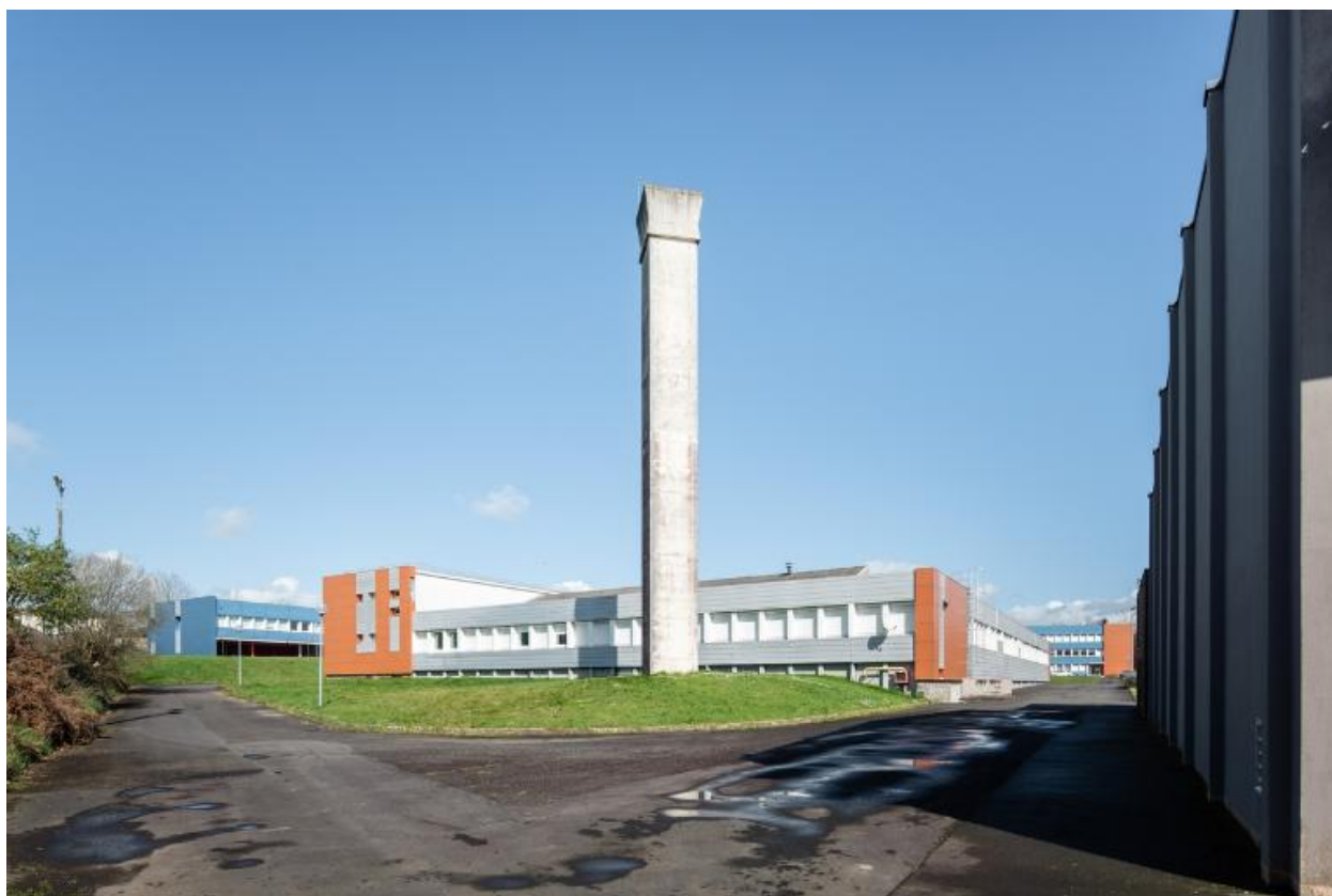
Bâtiment G, ateliers : façade sud-ouest, et cheminée de la chaufferie. Albert Hec et Roger Besnard, architectes, 1969.
