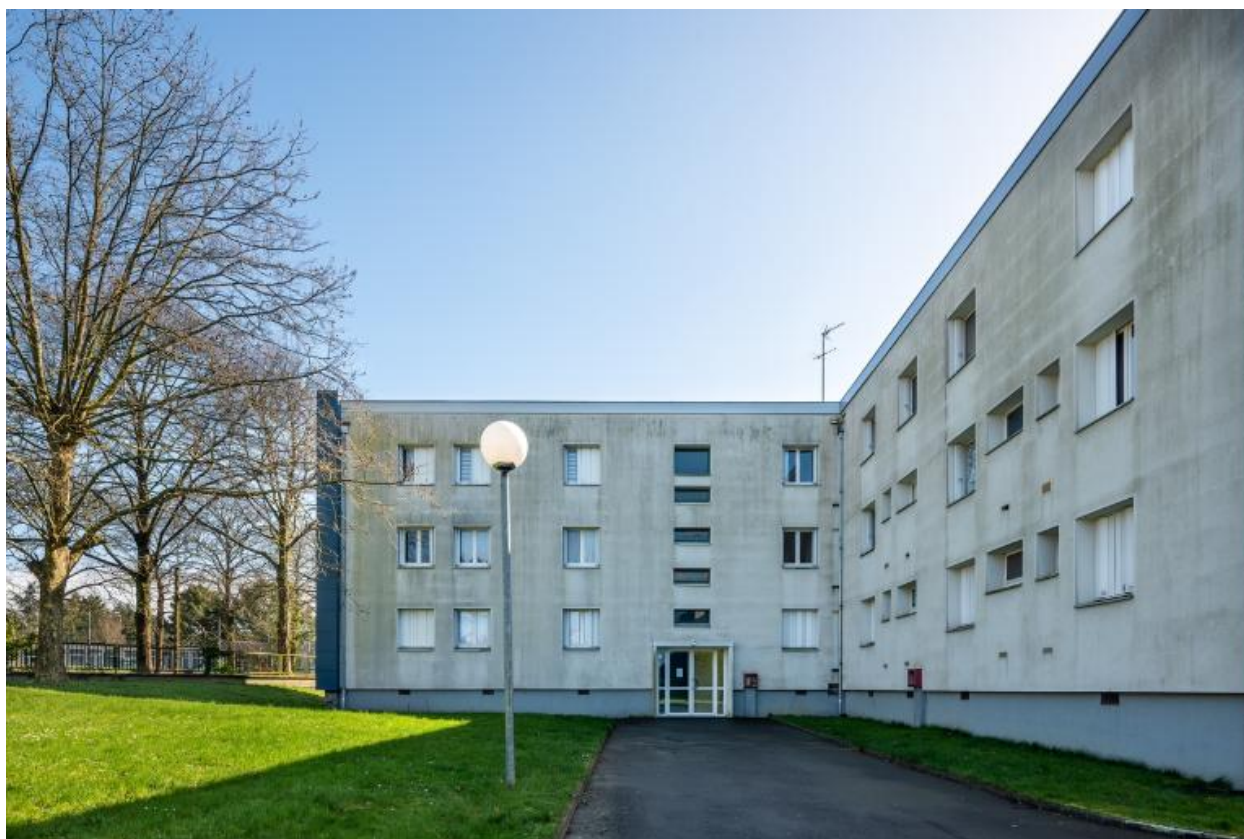
Bâtiment H, logements : façades ouest et nord. Albert Hec et Roger Besnard, architectes, 1969.
