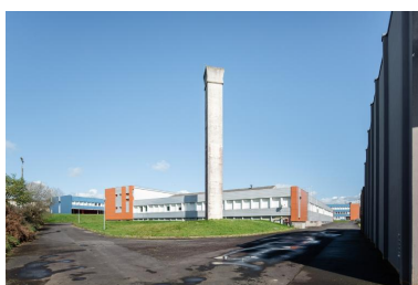
Bâtiment G, ateliers : façade sud-ouest, et cheminée de la chaufferie. Albert Hec et Roger Besnard, architectes, 1969. Phot. Delia Gaulin-Crespel IVR53_20203500387NUCA
