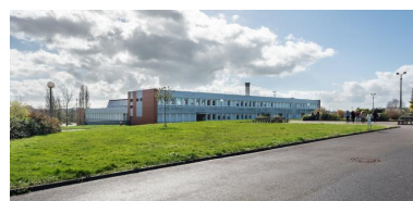
Bâtiment G, ateliers, vue d'ensemble prise du nord. Albert Hec et Roger Besnard, architectes, 1969. Phot. Delia Gaulin-Crespel IVR53_20203500367NUCA
