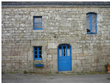
vue générale Phot. Jean-Pierre Martin IVR53_20185605631NUCA
