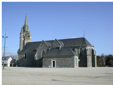
Vue générale sud-ouest Phot. Claude Quillivic IVR53_2001350881NUCA
