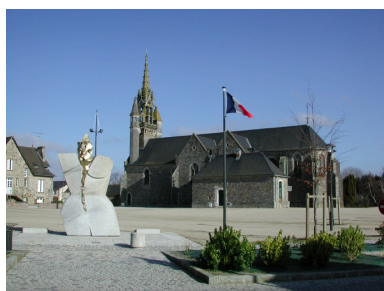
Vue de situation sud-ouest Phot. Claude Quillivic IVR53_20013508810NUCA
