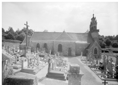
Vue générale nord Phot. Guy Artur IVR53_19752200097V
