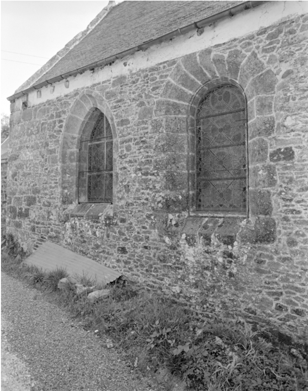
Fenêtres 1 et 2 du choeur, mur nord
