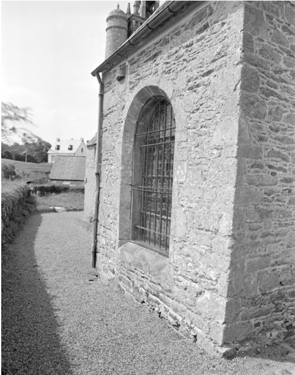
Fenêtres du transept sud
