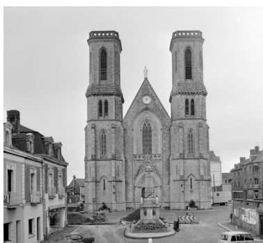
Elévation ouest : vue générale Phot. Guy Artur, Phot. Norbert Lambart IVR53_19943501486X
