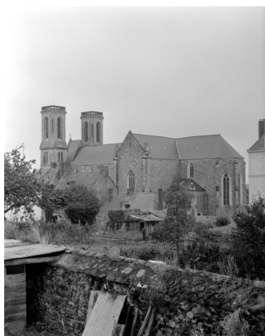
Elévation sud-est : vue générale Phot. Guy Artur, Phot. Norbert Lambart IVR53_19943501478X
