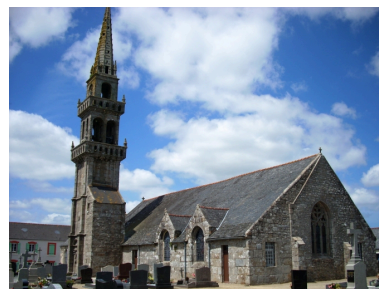
Saint-Vougay, église paroissiale Saint-Vougay : vue générale sud-est Phot. Gwénaél Fauchille IVR53_20082906357NUCA
