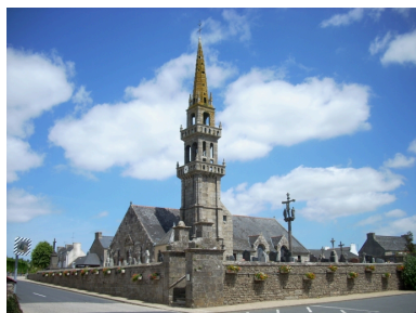
Saint-Vougay, église paroissiale Saint-Vougay : vue générale sud-ouest Phot. Gwénaél Fauchille IVR53_20082906355NUCA
