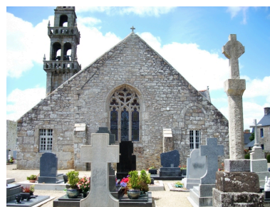
Saint-Vougay, église paroissiale Saint-Vougay : élévation est Phot. Gwénaél Fauchille IVR53_20082906360NUCA
