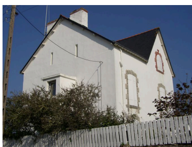
Villa 12 rue Madame Nestour, côté mer Phot. Johan Vincent IVR53_20062908686NUCA
