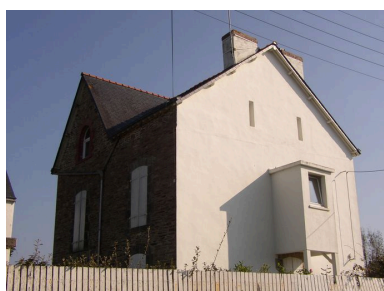
Vue générale de la villa 12 rue Madame Nestour, côté terre Phot. Johan Vincent IVR53_20062908685NUCA
