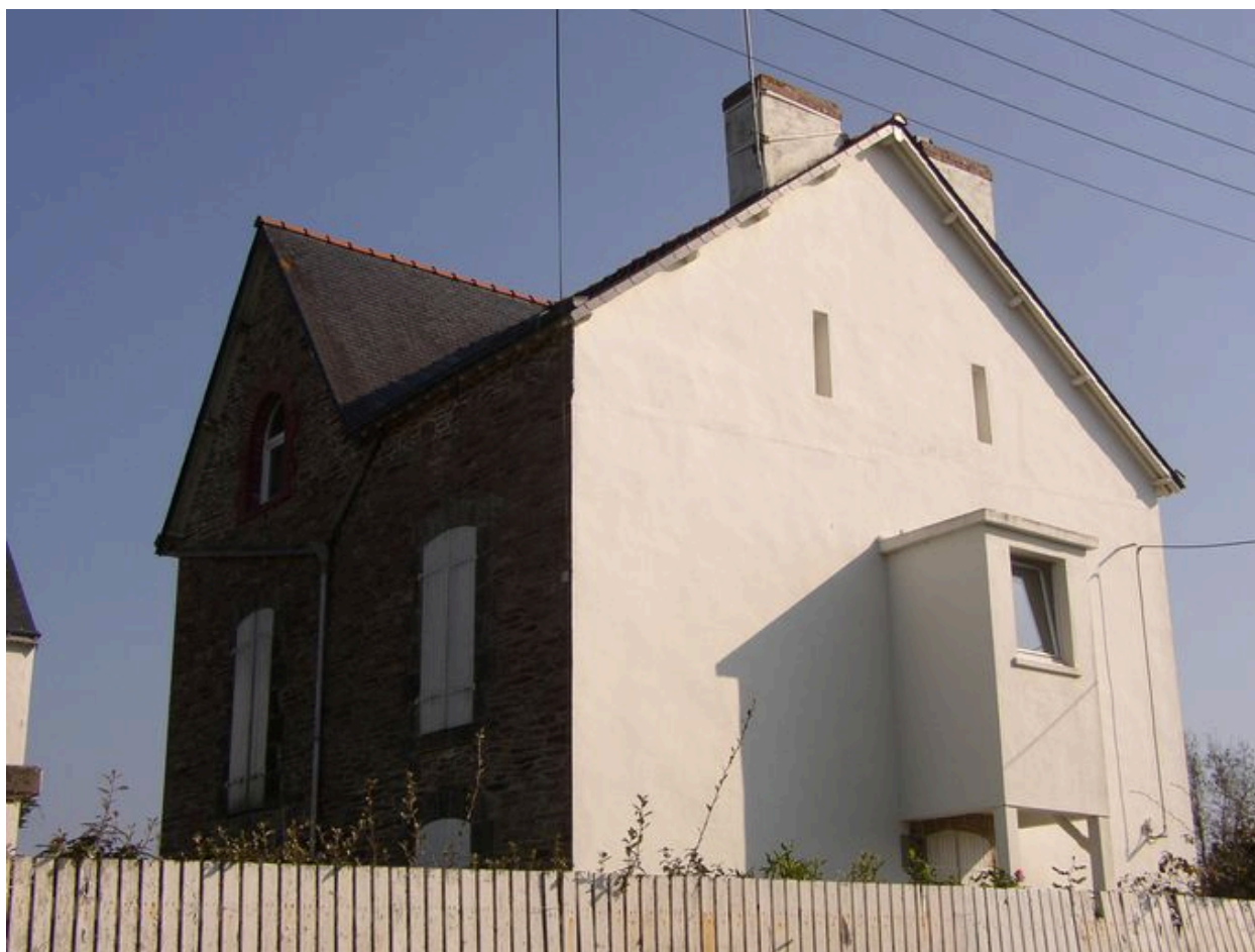
Vue générale de la villa 12 rue Madame Nestour, côté terre
