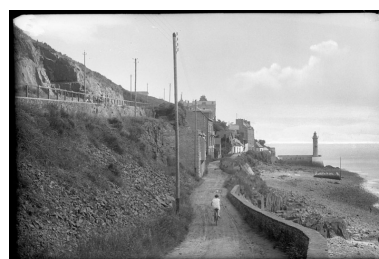
Le chemin du Phare : remarquer la route en construction au-dessus, sur la corniche, en 1936 (AD 22, Lacombe) Phot. Lacombe, Autr. Lacombe
