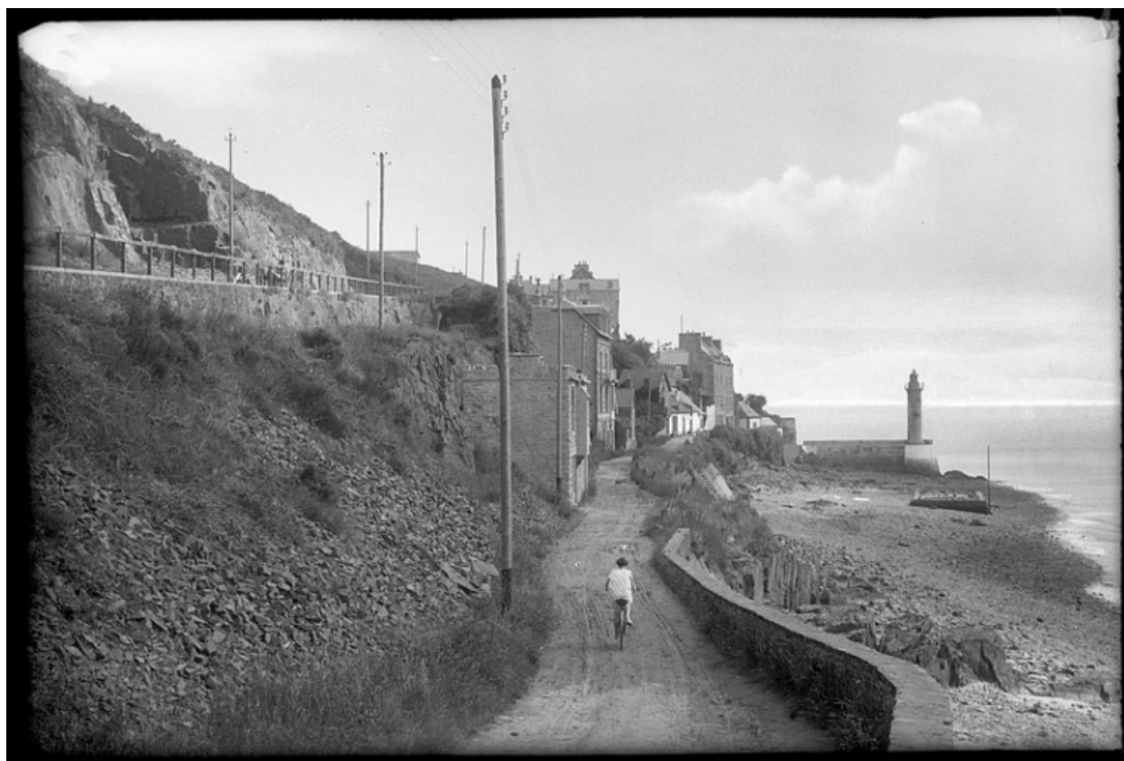
Le chemin du Phare : remarquer la route en construction au-dessus, sur la corniche, en 1936 (AD 22, Lacombe)
