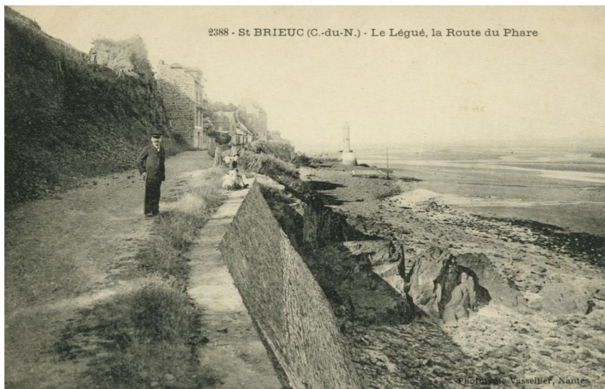
Vue du front de mer du Phare, vers 1908 : remarquer le mur-digue de soutènement et le vivier à grands crustacés dans la grève (carte postale, AD 22)
