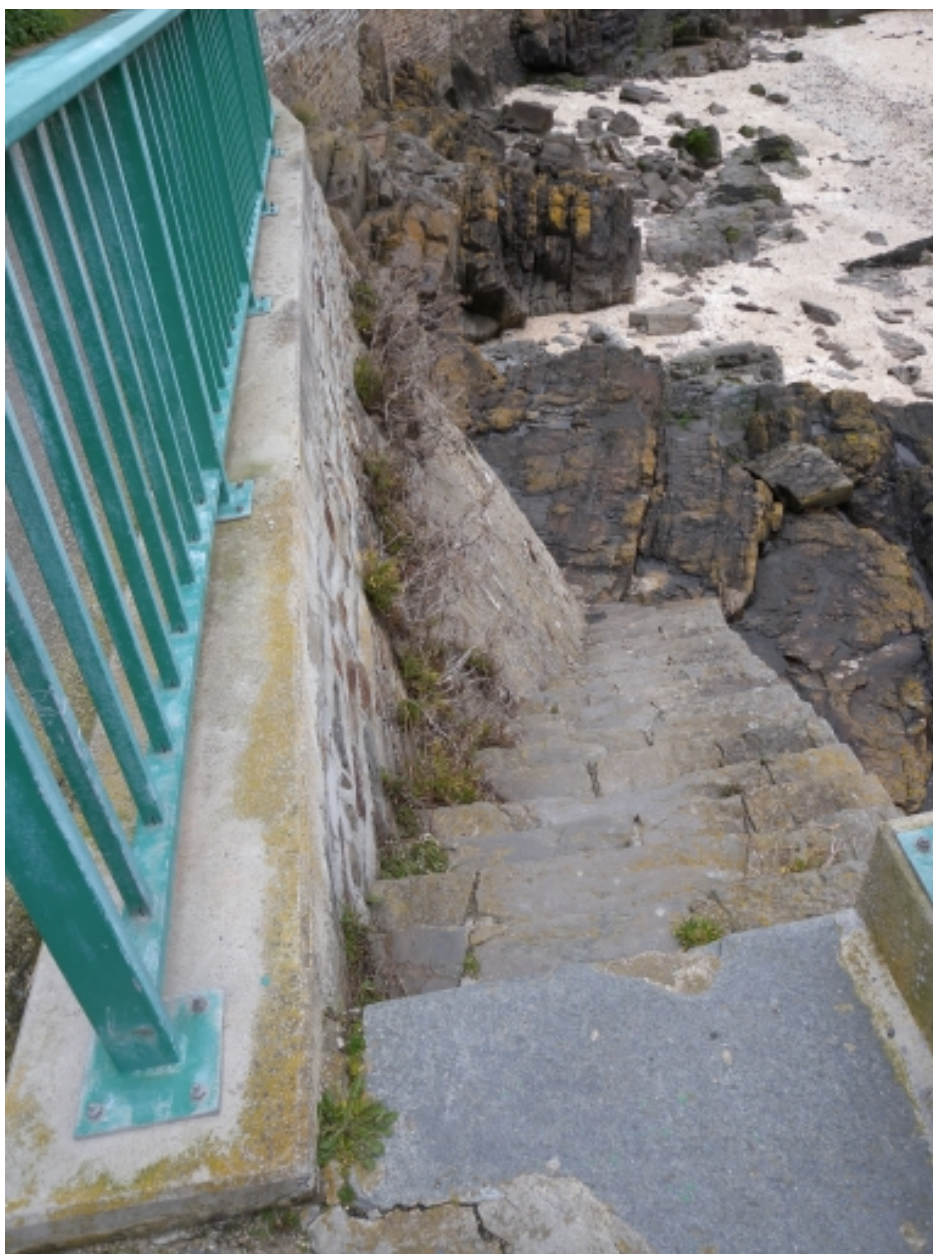
Vue de l'escalier de desserte à la grève, depuis le chemin du phare
