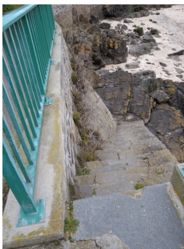
Vue de l'escalier de desserte à la grève, depuis le chemin du phare Phot. Guy Prigent IVR53_20082213209NUCA
