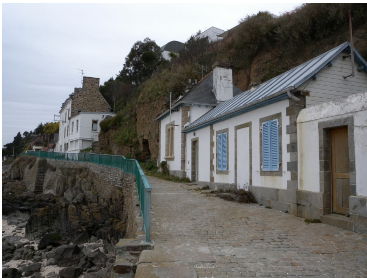
Vue de l'ancien bâti des Ponts-et-Chaussées (magasin aux huiles et maison du gardien du phare), aujourd'hui résidence privée
