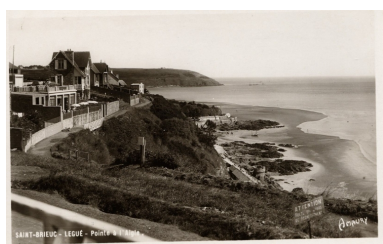
La corniche urbanisée vers 1933 (carte postale, AD 22) Phot. Amaury, Autr. Amaury IVR53_20082213046NUCB
