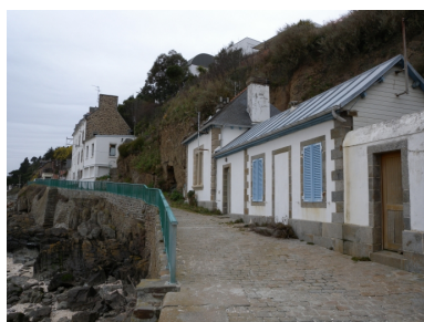
Vue de l'ancien bâti des Ponts-et-Chausssées (magasin aux huiles et maison du gardien du phare), aujourd'hui résidence privée Phot. Guy Prigent IVR53_20082213208NUCA
