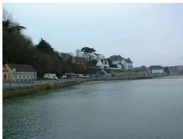
Front portuaire de Morgat Phot. Julien Amghar IVR53_20062908618NUCA
