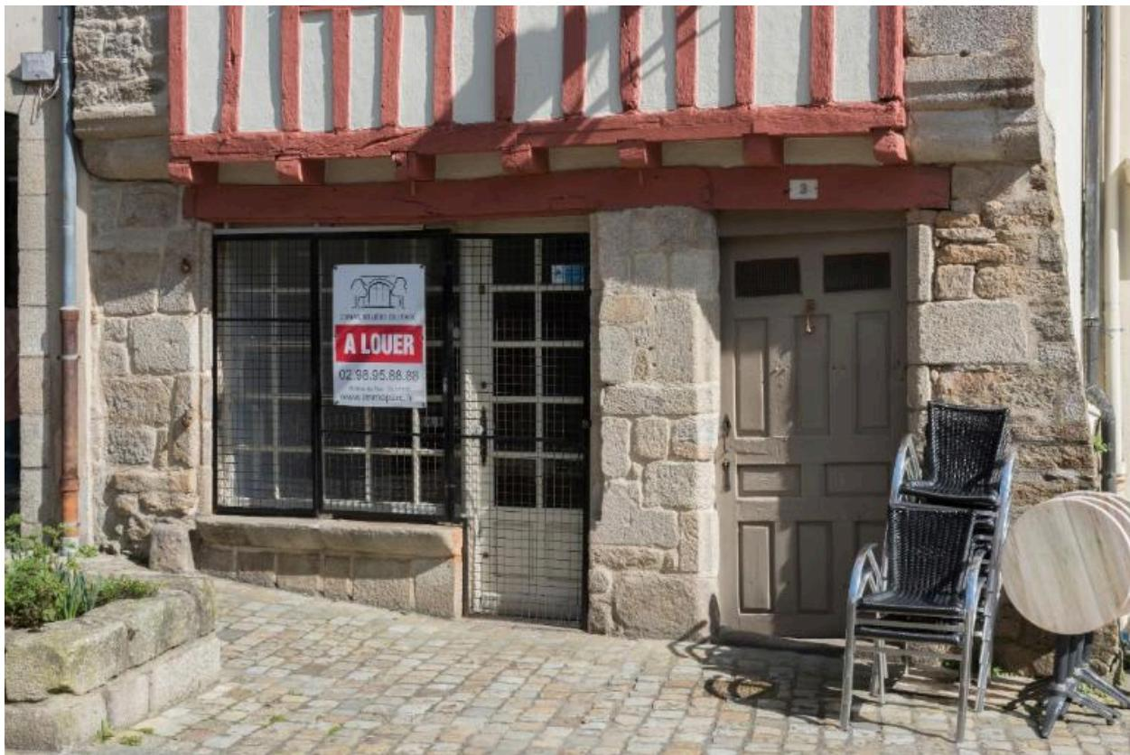
Le rez-de-chaussée maçonné intègre une large porte à droite ainsi qu'un étal commercial et porte attenante.
