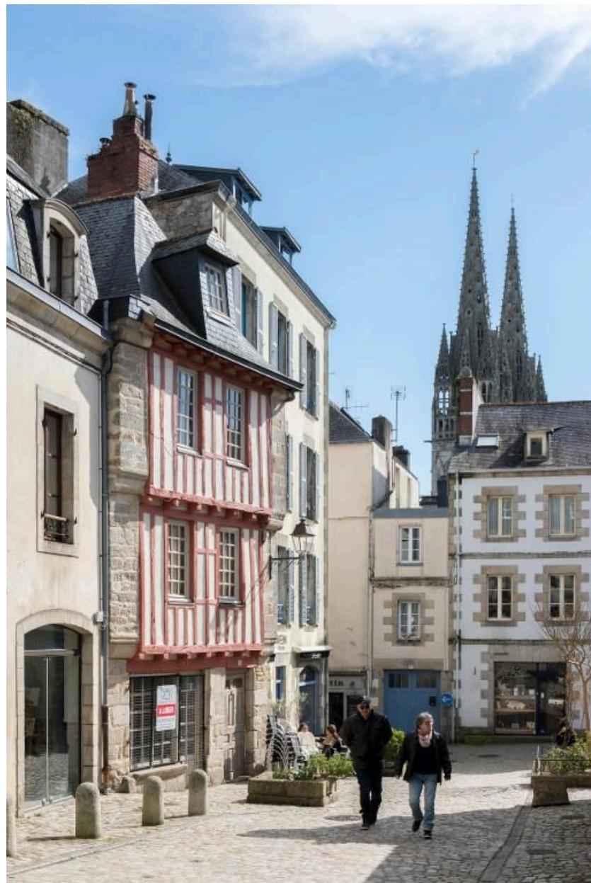
La façade en pan de bois s'ancre dans des murs maçonnés à ressauts.
