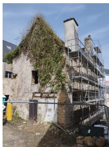
Façades arrière sur cour, état avant restauration. Phot. Hugo FEVE IVR53_20255610006NUCA
