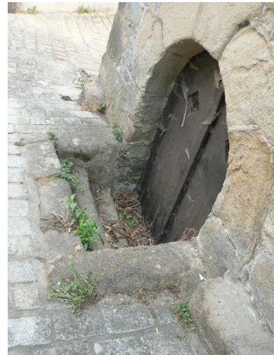
Une porte en plein cintre donne accès à la cave. Phot. Jérôme Cucarull IVR53_20245610300NUCA
