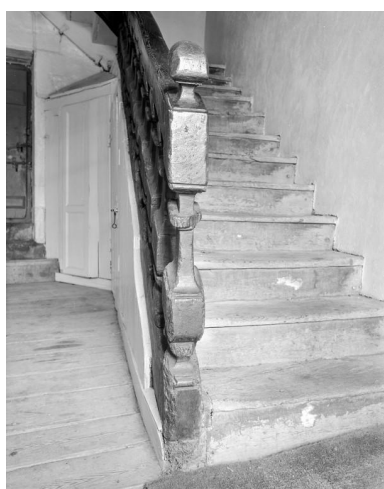
Départ du garde-corps de l'escalier. Phot. François Dagorn IVR53_19785601334X
