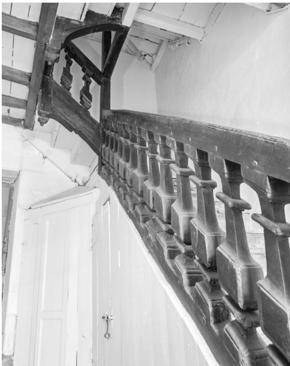
Escalier à balustres.
