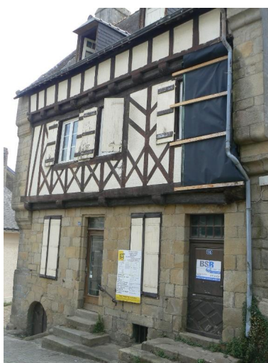
Façade à pan de bois avec encorbellement sur solives avant restauration Phot. Jérôme Cucarull
