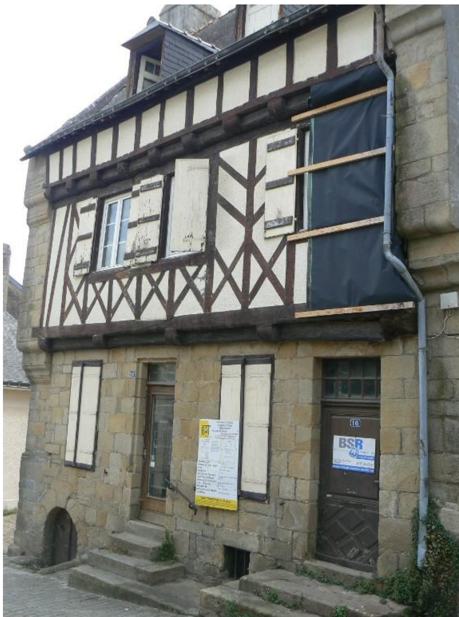
Façade à pan de bois avec encorbellement sur solives avant restauration
