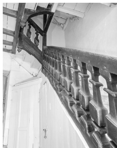
Escalier à balustres. Phot. François Dagorn IVR53_19785601333X
