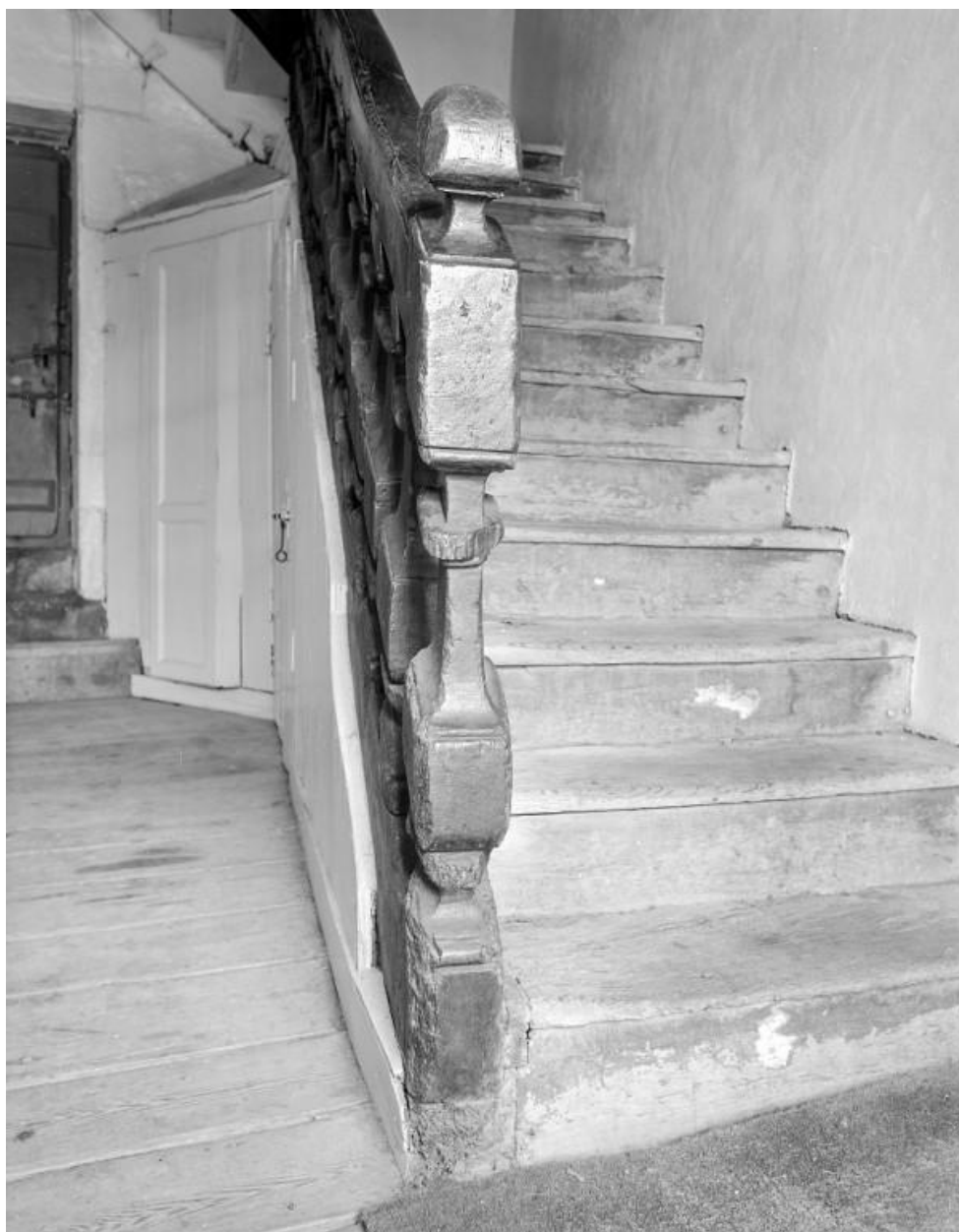
Départ du garde-corps de l'escalier.
