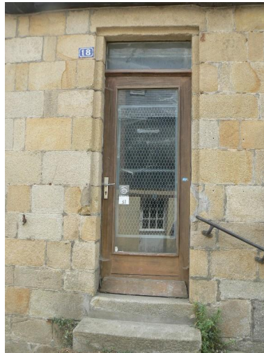
Détail d'une ancienne fenêtre transformée en porte. Phot. Jérôme Cucarull IVR53_20245610302NUCA
