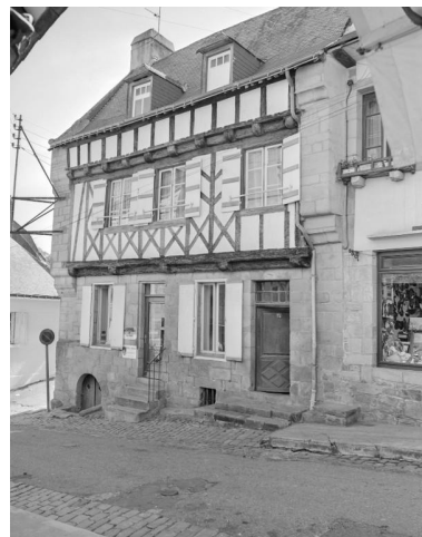
Façade gouttereau rue du Château. Phot. François Dagorn IVR53_19785601338X
