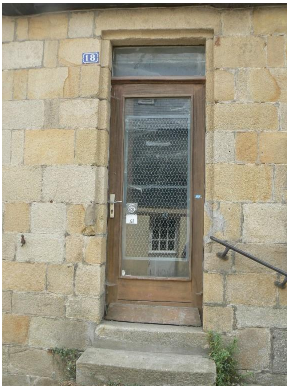
Détail d'une ancienne fenêtre transformée en porte.
