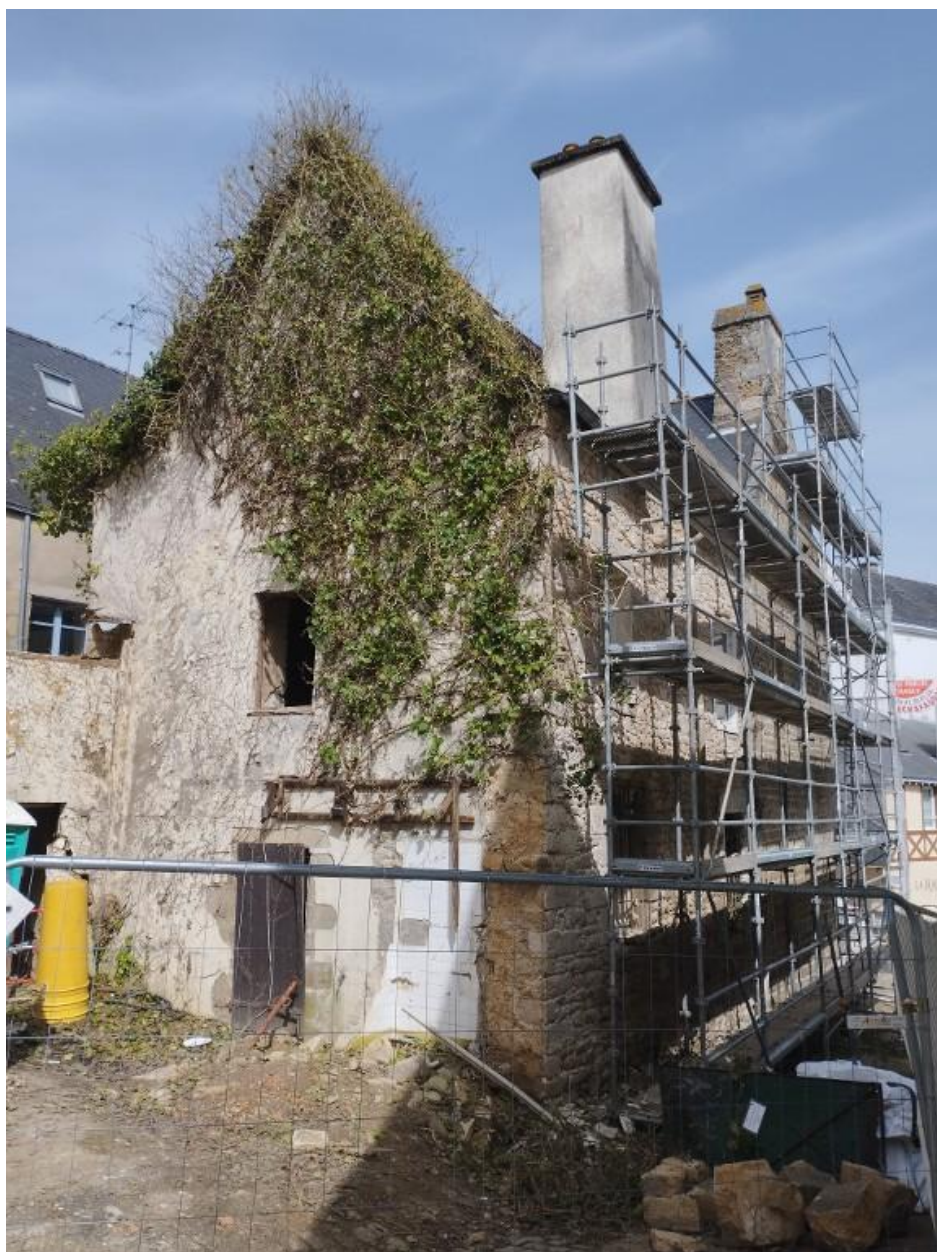
Façades arrière sur cour, état avant restauration.
