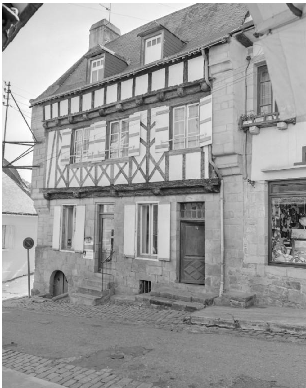
Façade gouttereau rue du Château.
