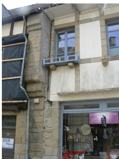
Mur mitoyen à ressauts. Phot. Jérôme Cucarull IVR53_20245610297NUCA
