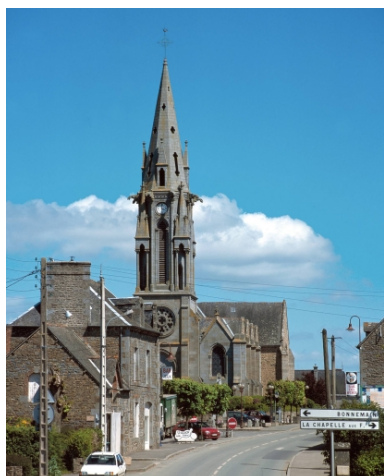
Le clocher de l'église dominant le bourg : vue de situation sud-ouest Phot. Guy Artur, Phot. Norbert Lambart IVR53_20013504023XA
