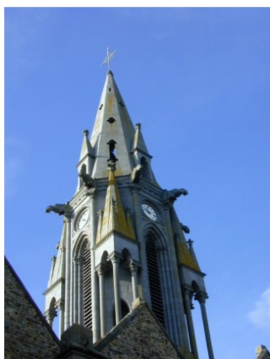
Le clocher : vue partielle nord-est Phot. Xavier Gilbert IVR53_20023508129NUCA
