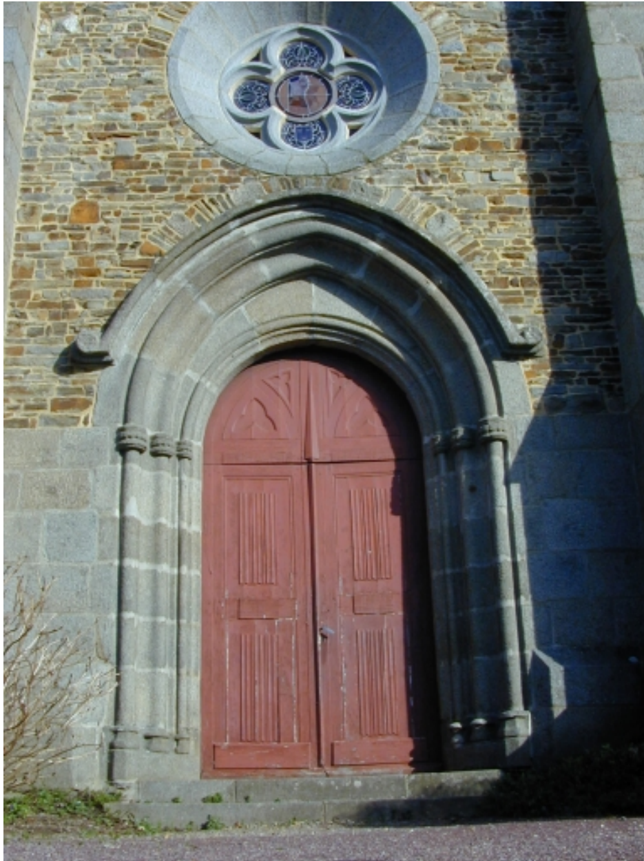
Longère sud, porte du XVe siècle remployée : vue générale sud
