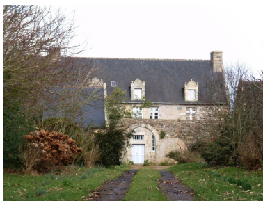
Vue générale (élévation antérieure sur cour) Phot. Patrick Pichouron IVR53_20102209446NUCA
