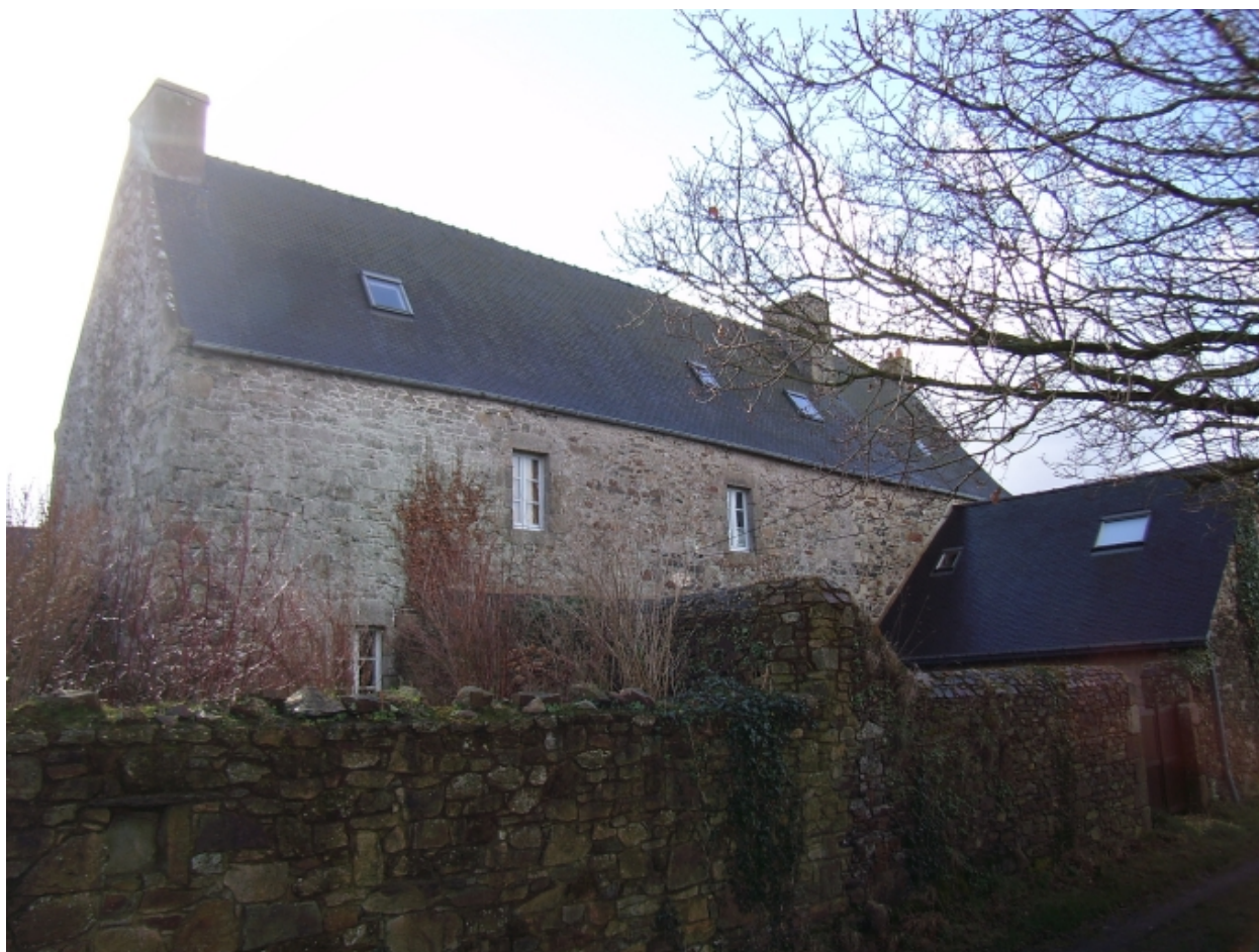
Vue générale (élévation postérieure)
