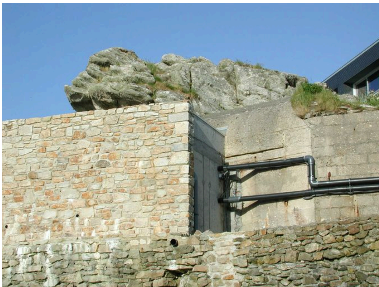
Vue de situation (état en 2002). La casemate bétonnée est intégrée aux installations de la Thalassothérapie de Roscoff
